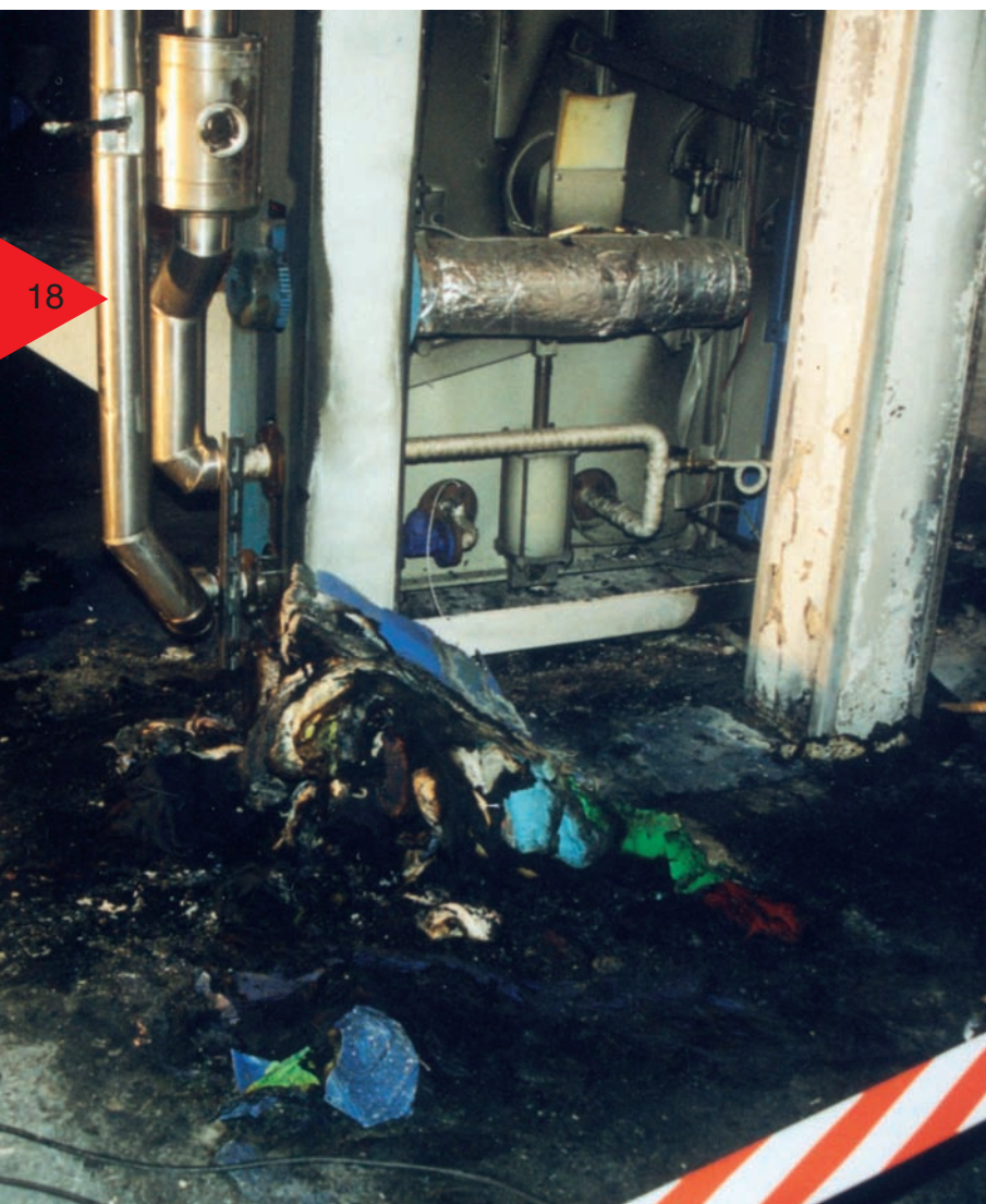
Bild 1: Brandherd in der Wäscherei im Bereich von getrockneter und zur Auslieferung bereitgestellter Wäsche
