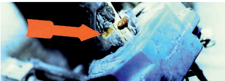
Mangelhafte Schraubbefestigung an einem vergleichbaren Stromwandler.
