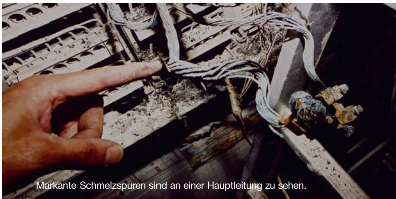
Die brandverursachende Stromkreisverteilung. Der Pfeil zeigt auf die primäre Schadenstelle.
