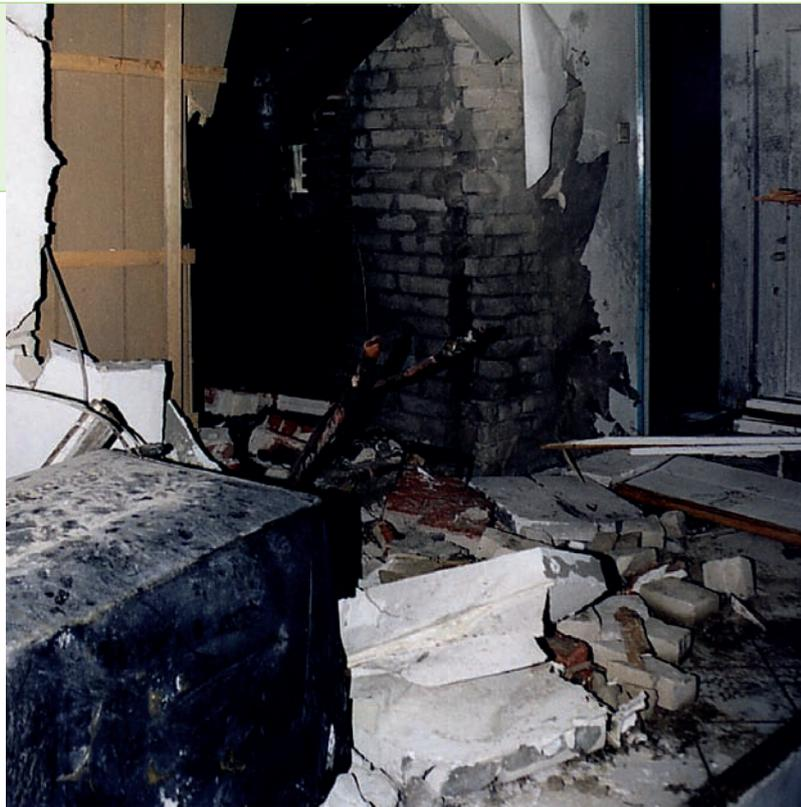
**Bild 1:** Der Kaminkessel im Bild unten links, nachdem er durch die Explosion von seinem Platz neben dem Schornstein im Wohnzimmer in den Flur geschleudert wurde.
