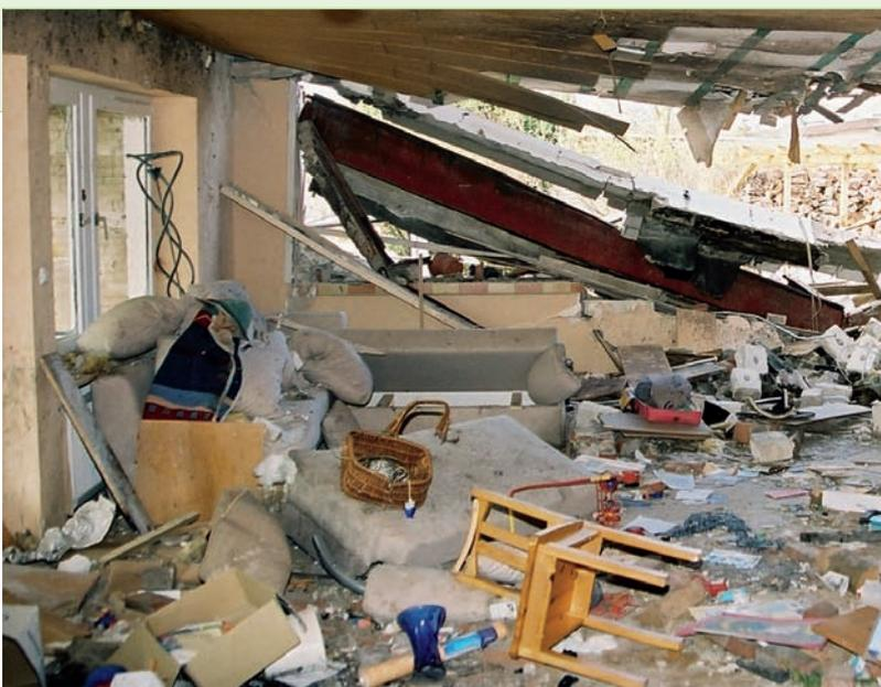
**Bild 3:** In der hinteren rechten Wohnzimmerecke stand der Kaminkessel vor der Explosion. Nach der Explosion wurde er an der Wand auf der linken Bildseite aufgefunden.
