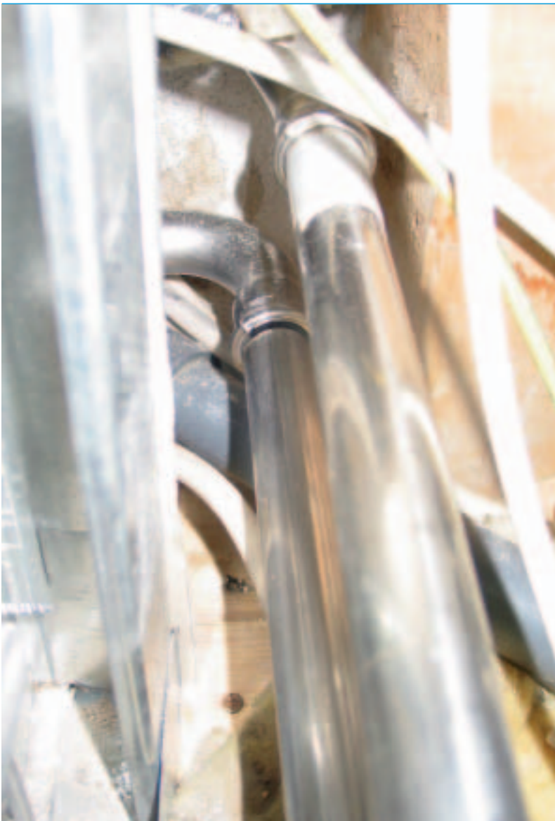
Bild 4: Eine fehlerhafte Verpressung an einer verdeckten Installation führte zu einem erheblichen Leitungswasserschaden.
