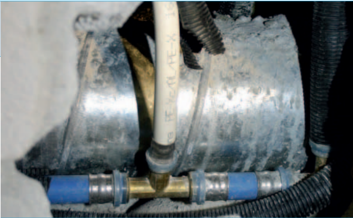
Bild 1: Pressverbindungen sind vielseitig und in den unterschiedlichsten Leitungssystemen einsetzbar.
