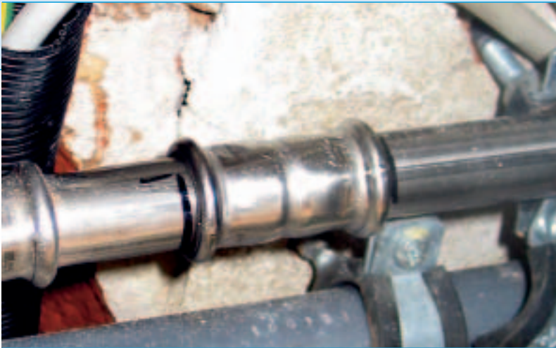
Bild 3: Eine korrekte Markierung der Einschublänge lässt Abweichungen sofort erkennen.
