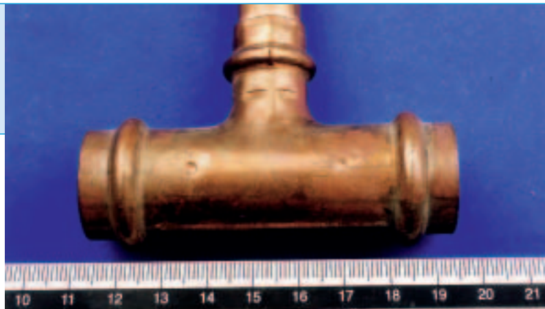
Bild 6: Das völlige Fehlen von Verformungen an den großen Pressmuffen belegt, dass an diesen Verbindungen nicht nur eine mangelhafte, sondern gar keine Verpressung ausgeführt wurde.
