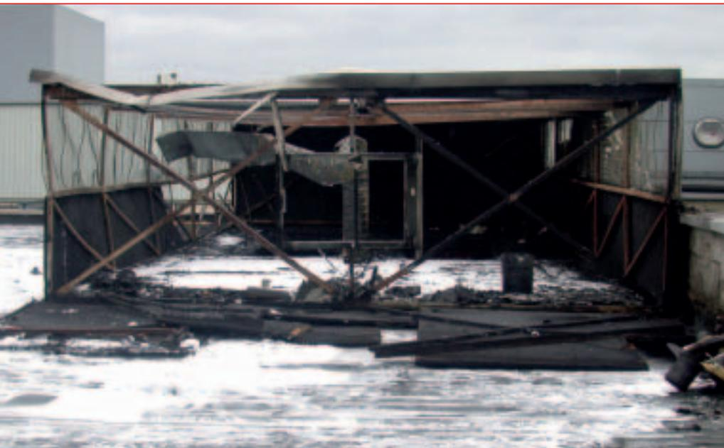
**Bild 1:** Das Gehäuse der Klimaanlage nach dem Feuer.
