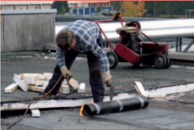
**Bild 2:** Schweißarbeiten auf dem Dach.
