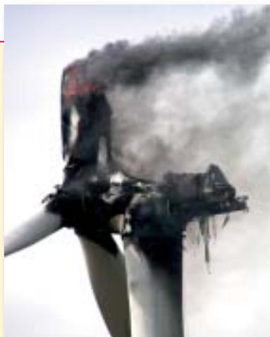
**Bild 2 und 3:** Brand nach einem Blitzinschlag bei einer 2 MW-WEA im Jahr 2004 (Bildquelle: HDI-Gerling)
