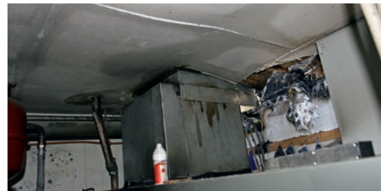
Bild 13 | Durch diesen Lüftungskanal oberhalb des Schallschutzgehäuses breitete sich der Brand in die Decke des BHKW-Raumes und auf den Dachboden aus.
