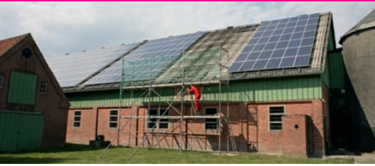
Bild 4 | Vom Brand betroffene Scheune mit Photovoltaikanlage. Die beschädigten Module wurden bereits entfernt.
