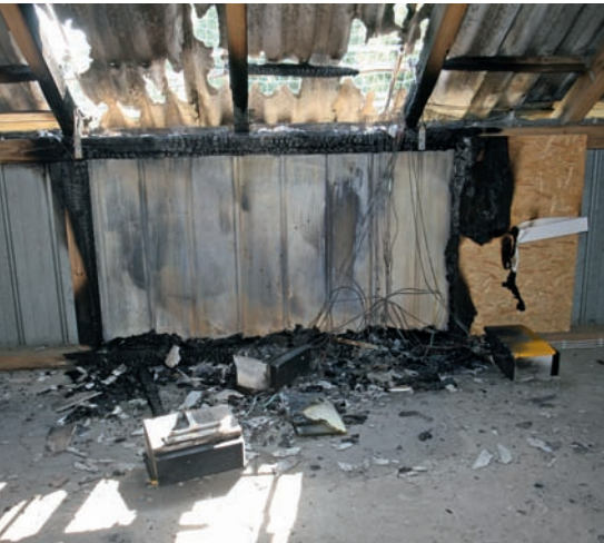
Bild 5 | Brandschwerpunkt ist der ehemalige Montageort einer Wechselrichtergruppe.
