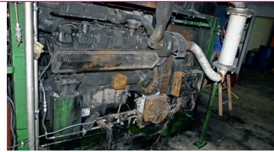
Bild 9 | Brandbetroffener Biogasmotor
