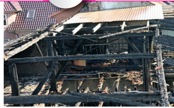
Bild 11 | Im Übergangsbereich zwischen Stall und Wohnhaus war das BHKW aufgestellt. Von dort war der Brand auf den Dachboden gelangt.
