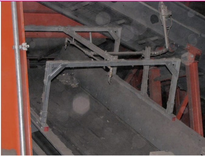
Bild 13 | Löschanlage als Objektschutz im Bereich einer Fördereinrichtung
