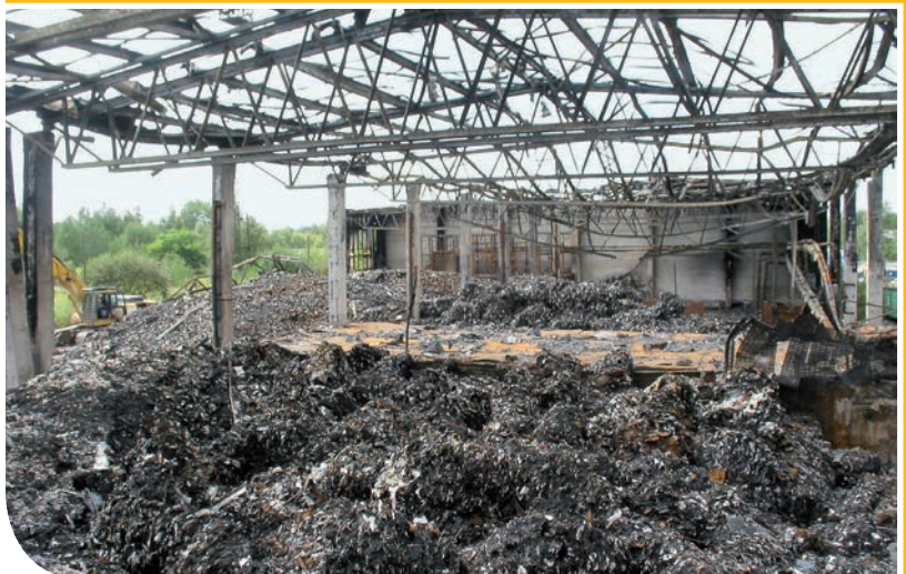
Bild 9 | Zu groß bemessene Brand- und Lagerabschnitte sowie eine fehlende Brandmelde- und Löschanlage führten zum Totalschaden
