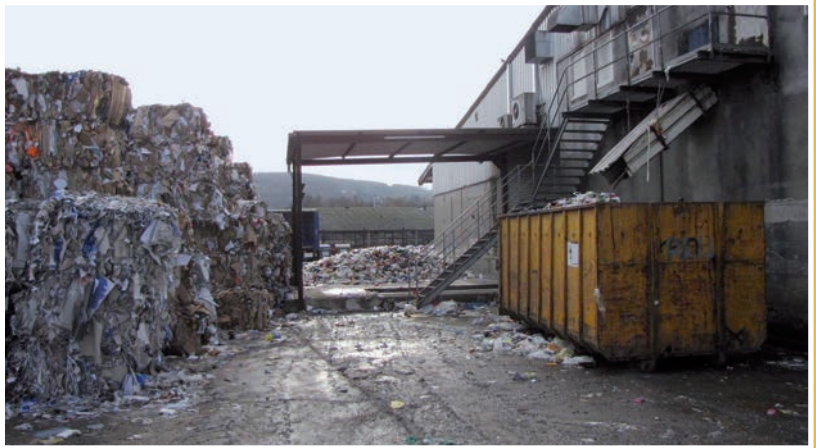
Bild 8 | Anlagerung der Verwertungsstoffe an eine Lagerhalle mit einhergehendem Totalschaden der Lagerhalle
