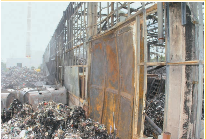
Bild 9 | Zu groß bemessene Brand- und Lagerabschnitte sowie eine fehlende Brandmelde- und Löschanlage führten zum Totalschaden
