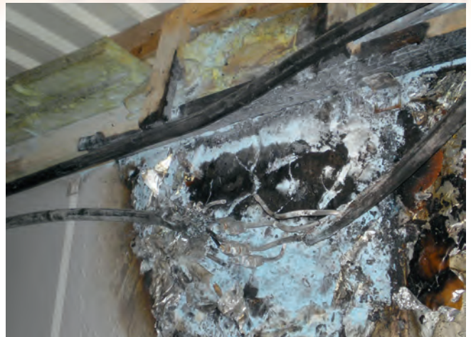
Bild 1 | Brandschaden durch mangelhafte Klemmverbindung
