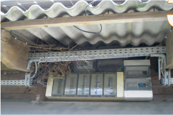
Bild 9 | Vogelnest auf Verteilung und Kabelbühne
