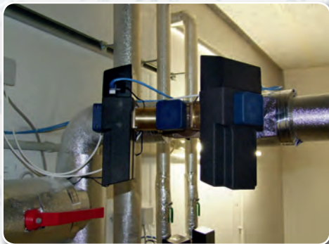
Bild 7 | Für zwei weitere Stränge der Wasserinstallation waren wegen der größeren Rohrdurchmesser sogenannte Duplexeinheiten mit je drei Leckagedetektoren vom Typ Safe-T-connect notwendig.
