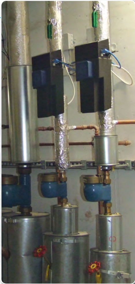
Bild 6 | Zwei zentrale Stränge der Wasserinstallation wurden mit Leckagedetektoren vom Typ Safe-T-connect ausgestattet.
