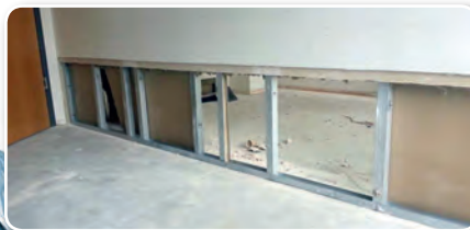
Bild 3 | Blick in einen vom Schaden betroffenen Raum. Die Teppichböden sind unbrauchbar geworden. An den Trennwänden mussten die unteren Teile entfernt werden.
