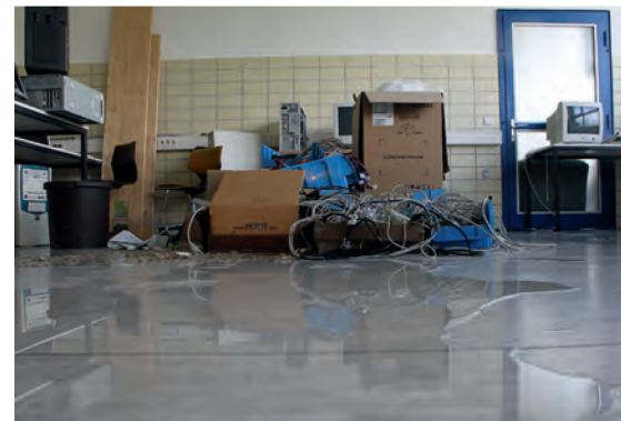
Bild 1–3 | Bilder von einem Wasserschaden in der Adolf-Reichwein-Schule in Marburg am 28. Mai 2012, Fotos: Michael Peter Hoffsteter, Gießen
