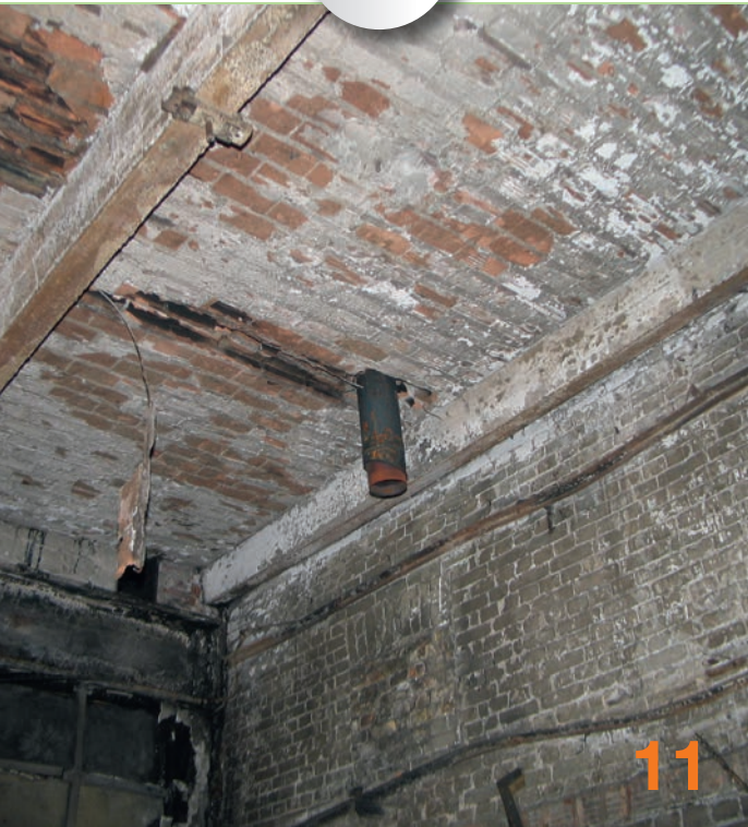
Bild 11 | Vgl. Bild 10 – Blick an die Raumdecke mit dem Rest der Abgasanlage
