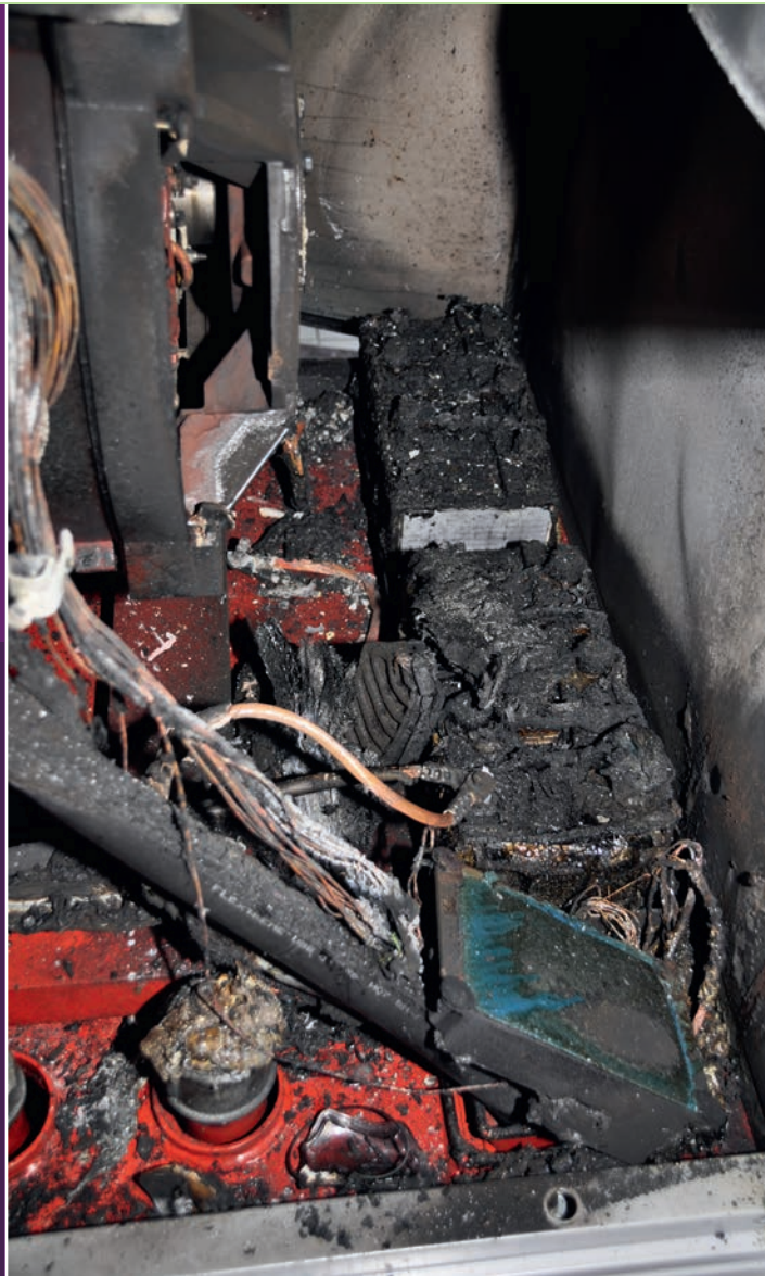
Bild 3 | Zwischen dem Generator und dem Außengehäuse des BHKW sind das Zündregelgerät und die Starterbatterien eingebaut.
