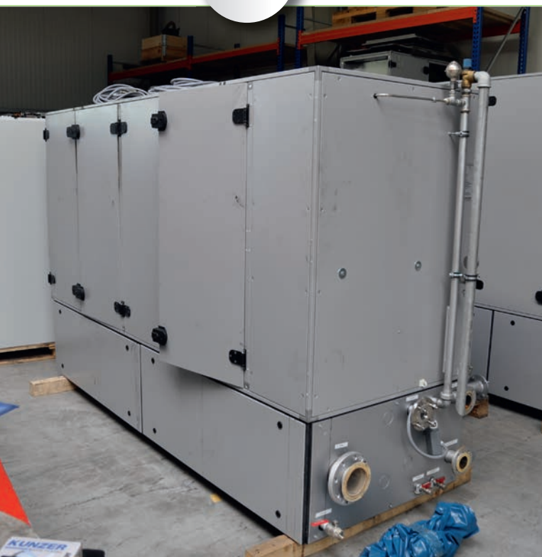
Bild 1 | Außenansicht eines der brandbetroffenen Blockheizkraftwerke
