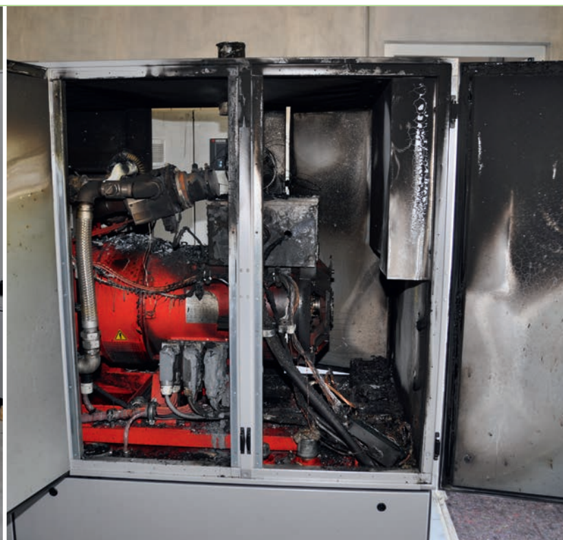
Bild 2 | Darstellung der Brandschäden am zweiten brandbetroffenen BHKW im Bereich des Generators
