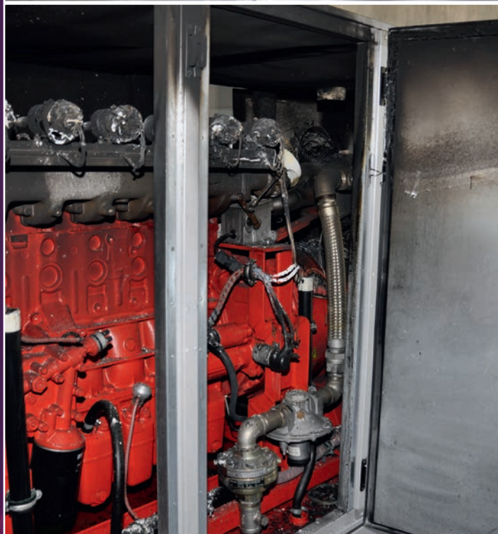
Bild 4 | Anblick der Ansaugseite des Gasmotors im zweiten brandbetroffenen BHKW
