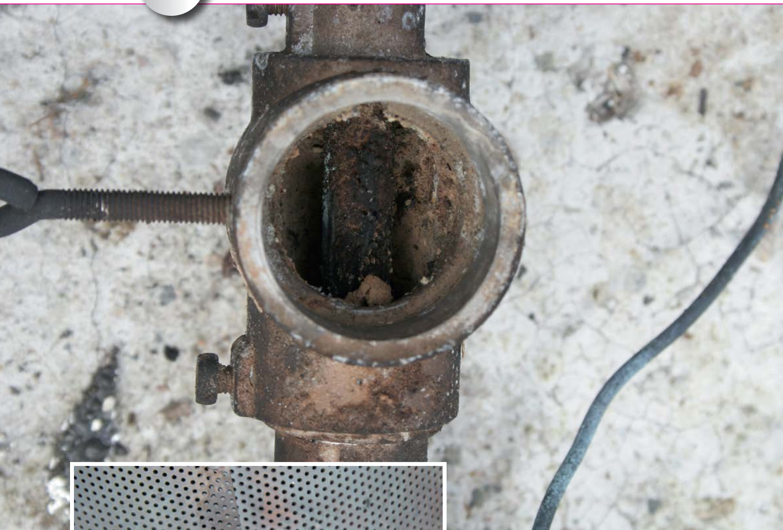
Bild 9 | In einem Gas-Wärmestrahler, der in einem brandbetroffenen Stall installiert ist, sind im Bereich der Verbrennungsluftansaugung ausgeprägte Ablagerungen von Staub, Futtermitteln oder Ähnlichem vorhanden.
