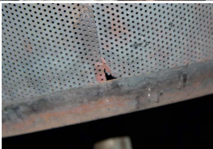
Bild 8 | Detailaufnahme eines zum Brandzeitpunkt betriebenen Gas-Wärmestrahlers, bei dem sich ein Stück des Lochprofilbleches vermutlich durch eine Verzunderung abgelöst hatte. Dieses Metallteilchen konnte dann glühend in die aus Stroh bestehende Einstreu fallen und diese entzünden.
