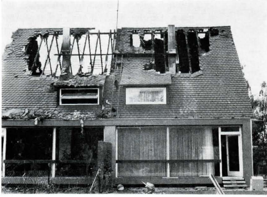
Bild 2. Das Antennenstandrohr war mit einem isolierten Kupferdraht von 4 mm 2 Querschnitt geerdet. Die Leitung wurde durch einen Blitz verdampft, das Dach teilweise abgedeckt und der Dachstuhl in Brand gesetzt.
