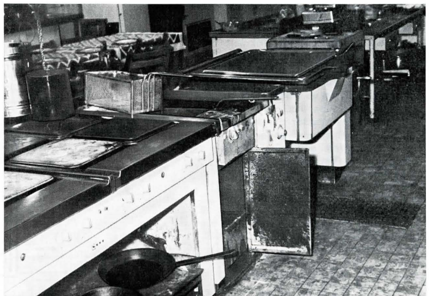
Bild 4. Infolge eines Versagens des Schaltschützes in Brand geratene Großküchenfritüre. Durch die Installation der Fritüre als Einbauelement blieb der Brand lokal beschränkt. Der Brandschaden am Gerät betrug dabei 2500 DM, der durch die Brandgase verursachte Folgeschaden 15 000 DM.
