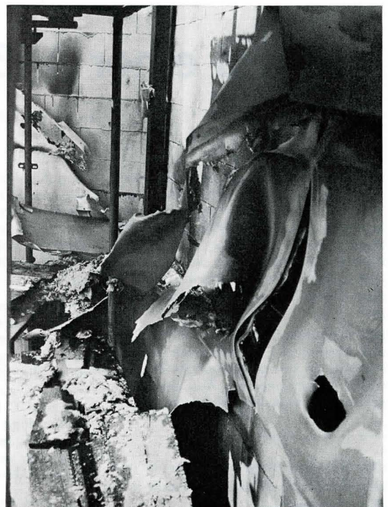
Bild 2. Vom Brand deformierte und abgetropfte vorgehängte Alu-Blech-Fassade.
