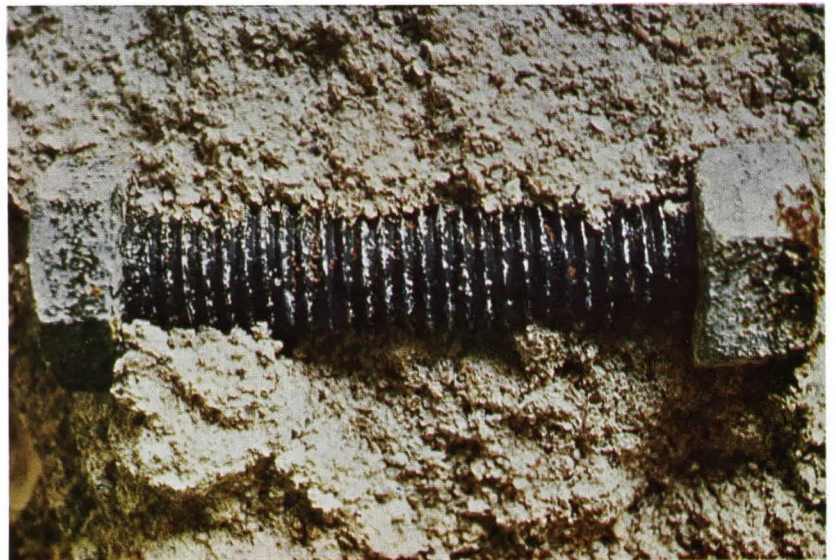
Bild 9. Leichte Korrosionen bei den Mörtelproben an den Bolzenenden und beginnende Korrosion am Schaft, d. h. eindeutig im Bereich außerhalb der Chlorideinwirkung (Außenlagerung).
