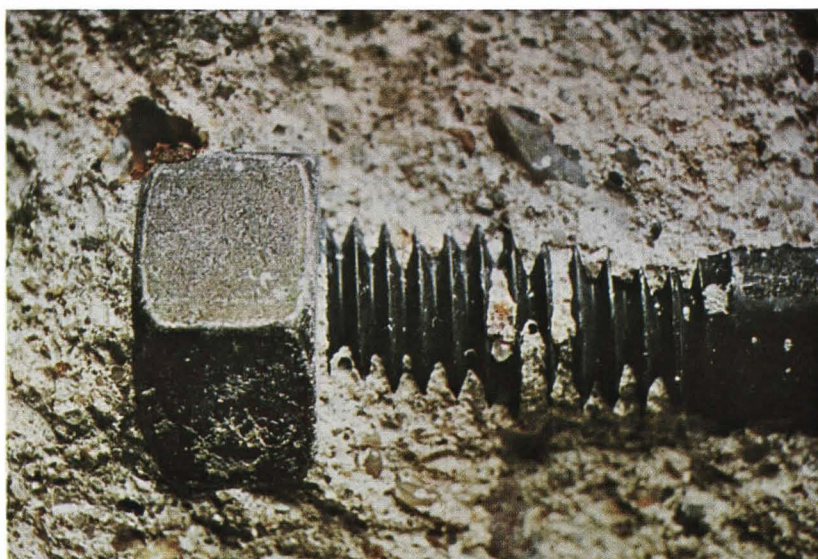
Bild 5. Korrosionen am Stahl in Betonprüfkörpern. Die Korrosionen traten jedoch lediglich an Stellen mit unzureichender Ummantelung (Lunkerstellen) auf.
