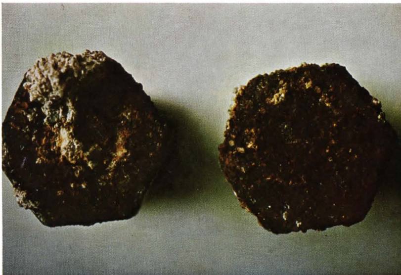
Bild 10. Starke Korrosionsmerkmale an Bolzenköpfen bei Mörtelproben (Außenlagerung).
