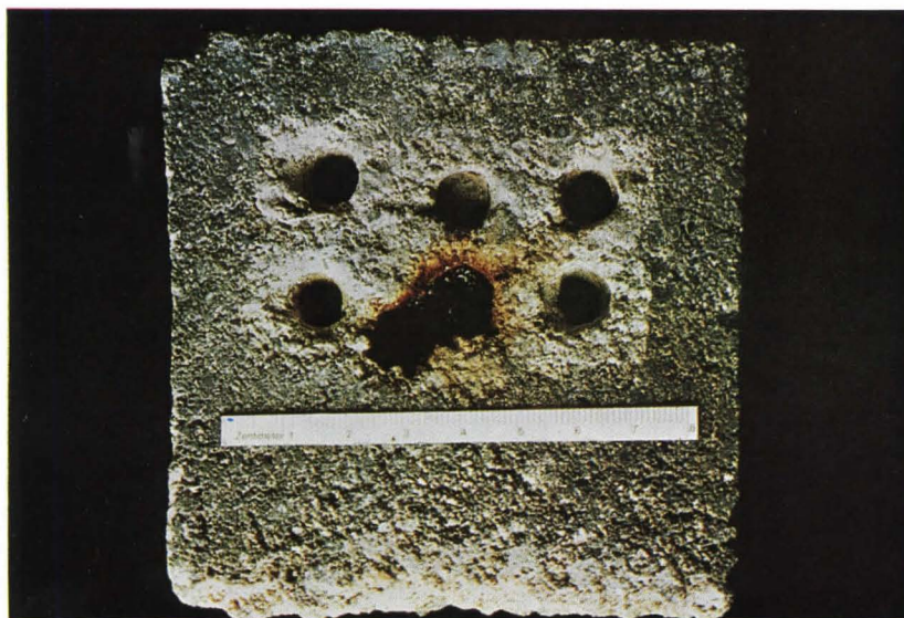
Bild 6. Wurde bei der Probennahme zufällig die Stahleinlage freigelegt (hier Mörtelprüfkörper), so führt es bei der Außen- und bei der Unterwasserlagerung zu Korrosionen mit Ausbluteffekt.
