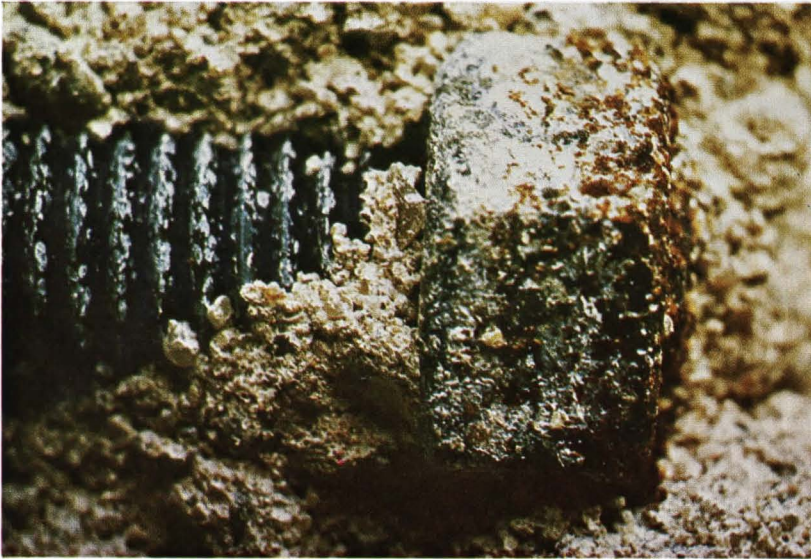
Bild 8. Typische Korrosion am Bolzenkopf bei den Mörtelproben. Derartige Merkmale fehlten bei den Betonproben völlig (Außenlagerung).
