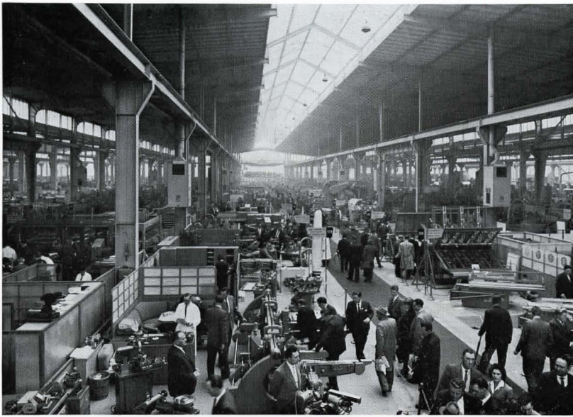
Bild 6. Halle in ungeschützter Stahlkonstruktion.
