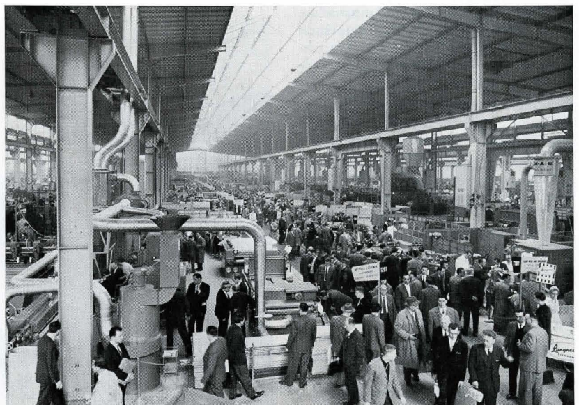
Bild 3. Blick in eine der Hallen, die zu dem ehem. Industriebetrieb gehörten.
