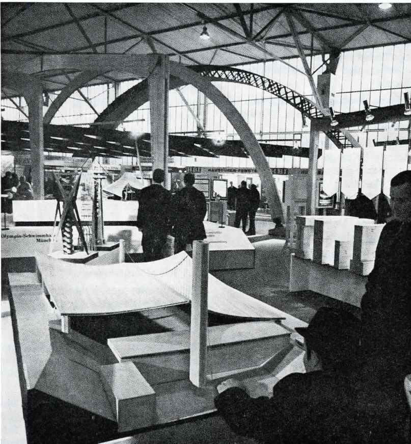
Bild 9. Ausstellungsgegenstände aus brennbaren Baustoffen in einer Halle mit ungeschützter Stahlkonstruktion während der CONSTRUCTA.
