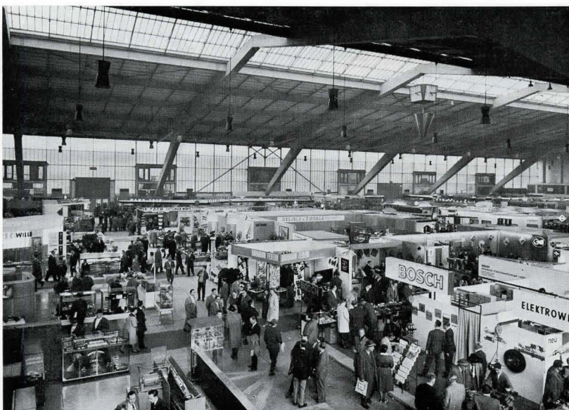
Bild 5. Eine Halle mit ummantelter Stahlkonstruktion.
