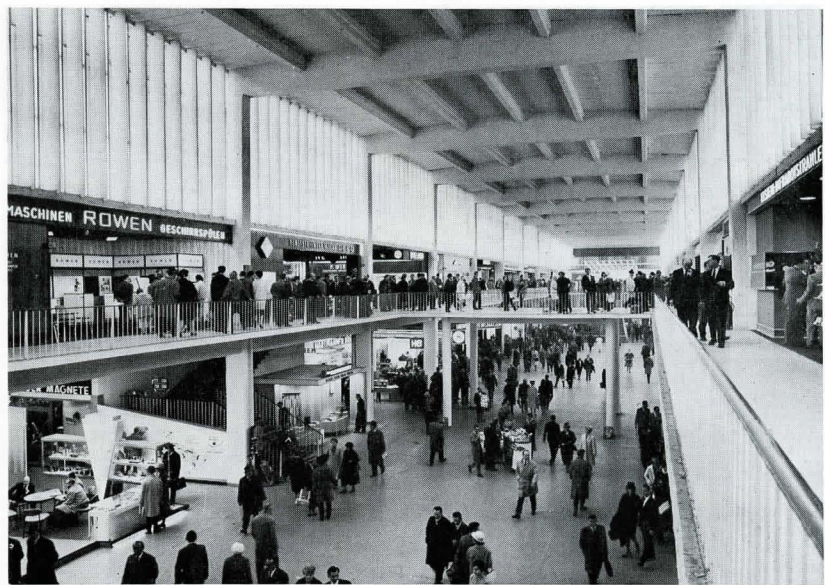
Bild 4. Eine der neueren Hallen in Stahlbetonkonstruktion.
