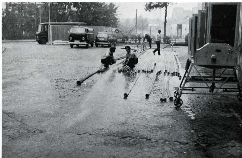
Bild 4. Prüfung und Reinigung von Feuerlöschschläuchen
