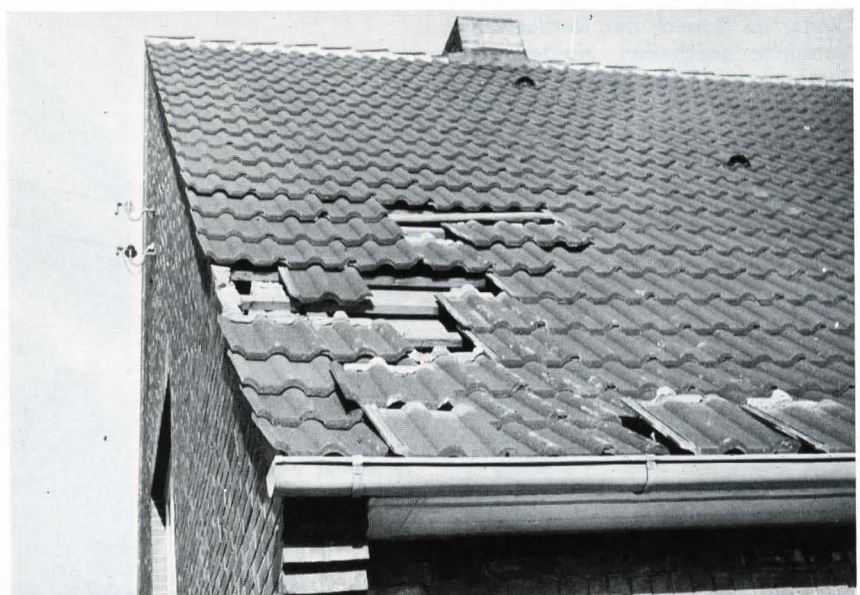
Bild 4. Schäden treten oft an der dem Wind abgekehrten Seite des Ortanges auf.
