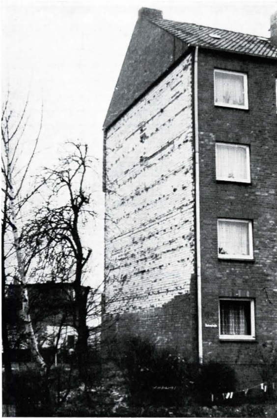
Bild 11. Das Verblendmauerwerk der Giebelwand wurde durch Sog abgerissen. Die Verbindung zum Hintermauerwerk war nicht ausreichend.
