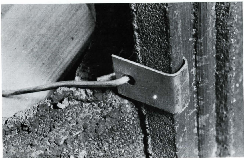
Bilder 6 und 7. Seitenfalzklammer für Betondachziegel. Diese Verklammerungsart hat sich im Gegensatz zur Kopfnagelung gut bewährt.
