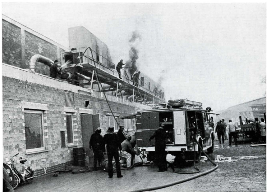
Bild 1. Funken haben einen Filterbrand verursacht.
