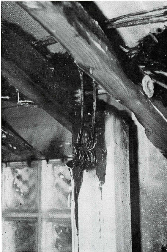
Bild 8. Brandschaden durch Lichtbogenkurzschluß infolge Feuchtigkeit in einer elastischen nicht feuchtigkeitsdichten Kunststoffabzweigdose
