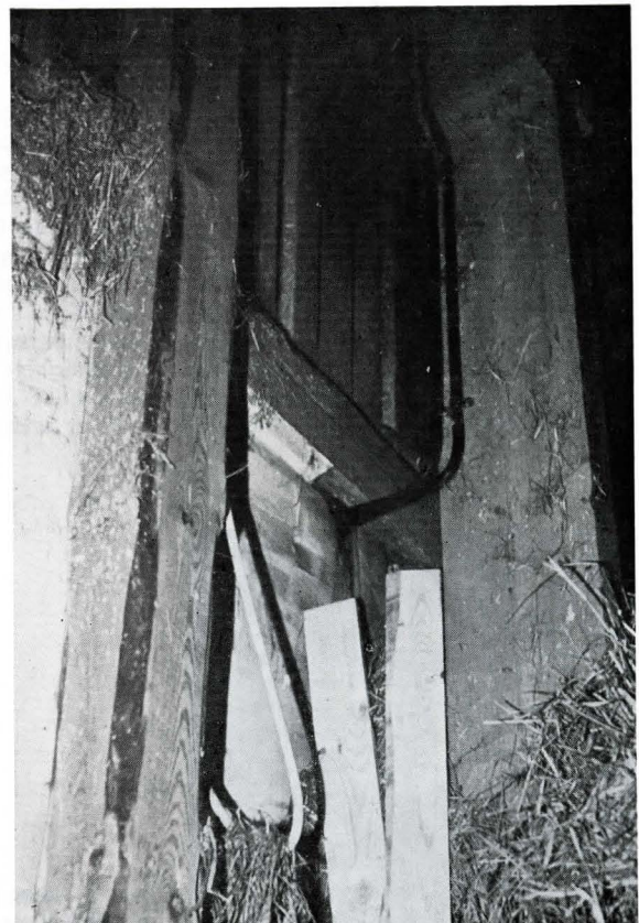
Bild 7. Gedankenlose Führung von hier nicht benötigten Leitungen durch feuergefährdete Räume
