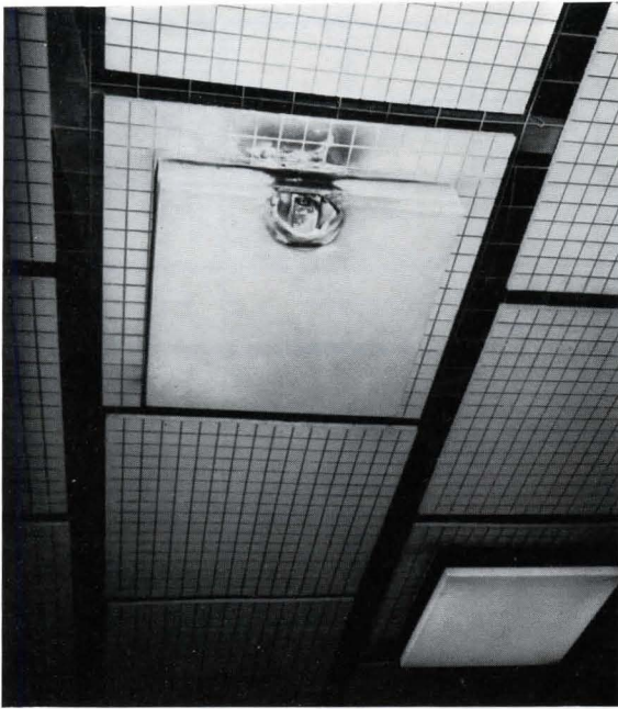
Bild 9. In einer Kassenhalle erhitzte sich die Drossel in einer Leuchte so stark, daß sie die Abdeckwanne in Brand setzte.
