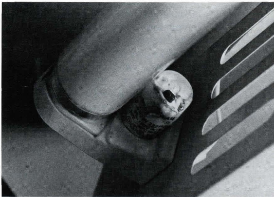
Bild 7. Durch die Wärmeentwicklung an den Lampenelektroden wurde das Gehäuse des Sicherheitsstarters deformiert, so daß die Abschaltmechanik klemmt. Der Abstand zwischen Lampe und Starter ist zu gering.
