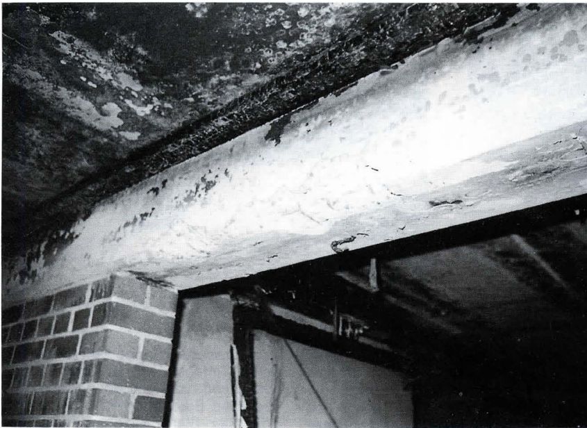
Bild 1. Stahlbetonsturz und Stahlbetondecke, beide thermisch beschädigt
