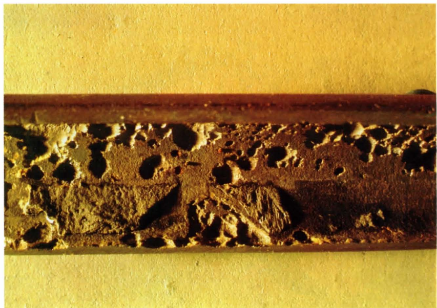
Abb. 4. Korrosion eines Stahlrohres infolge ungleichmäßiger Verzinkung. (Die überdeckenden Korrosionsprodukte wurden mit inhibierter Säure entfernt)
