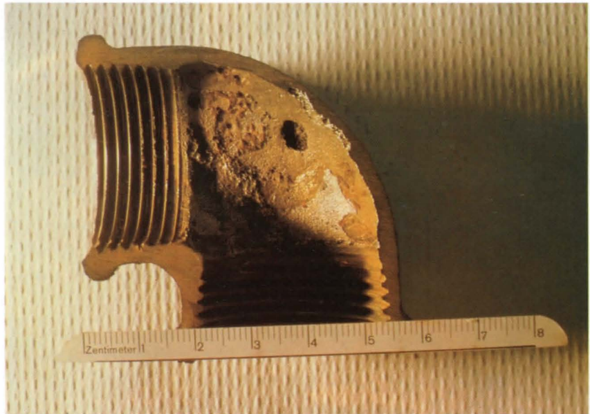
Abb. 7. Korrosion eines Stahlrohrfittings durch Gewindeschneidespäne
