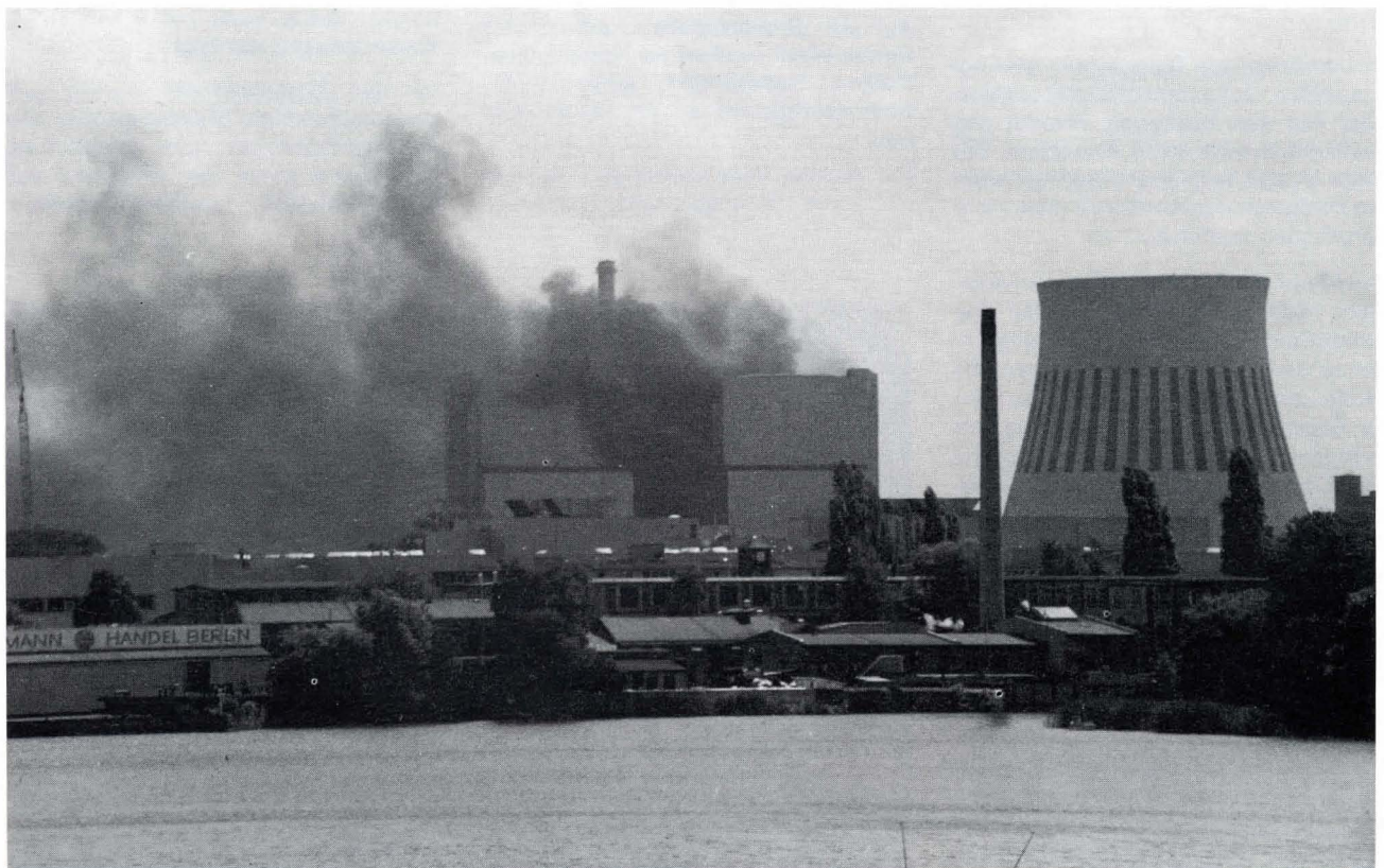
Bild 5. Brand von Isoliermaterial während der Bauphase auf der Großbaustelle „Kraftwerk Reuter-West“
