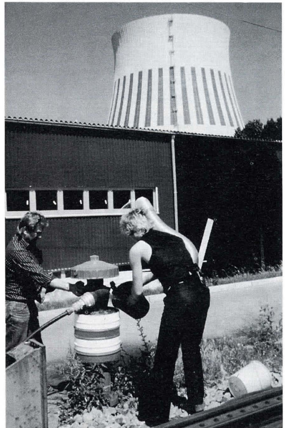
Bild 9. Überflurhydrant
