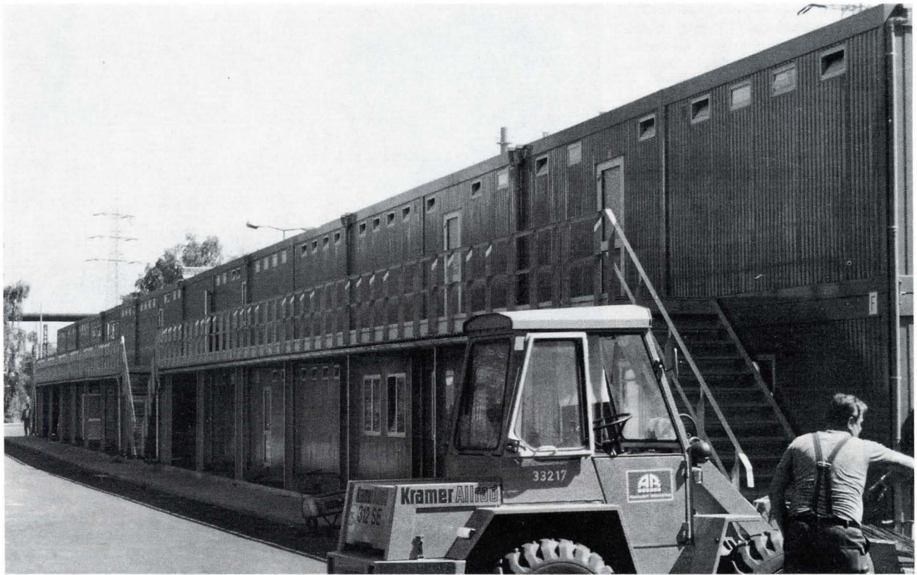
Bild 2. 2geschossige Baustellen-Container – von 6,00 m Länge und 2,50 m Breite je Container – insgesamt 16 Container
