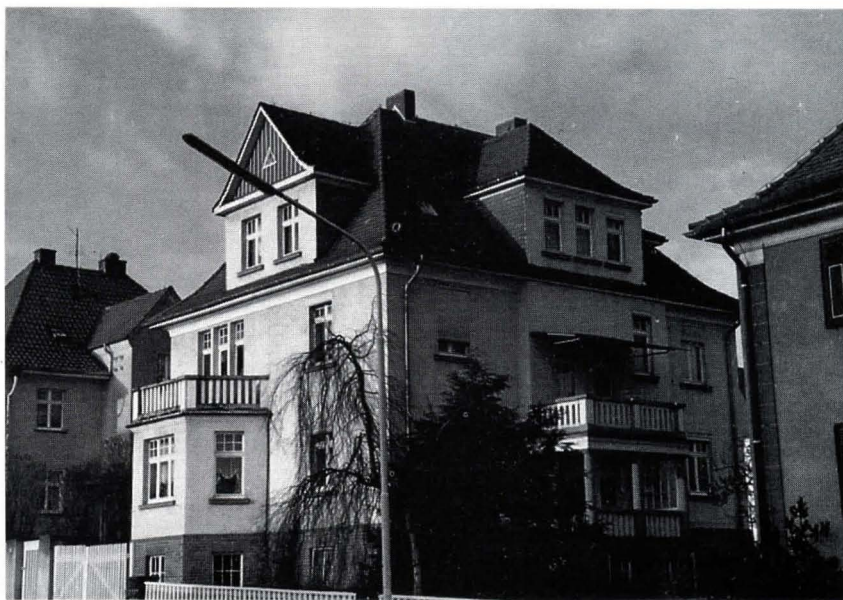
Bild 1. Vom Schaden betroffenes Haus
