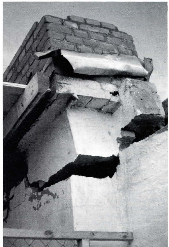
Bild 4. Von Sturmböen abgebrochener und herausgerissener Schornsteinkopf
