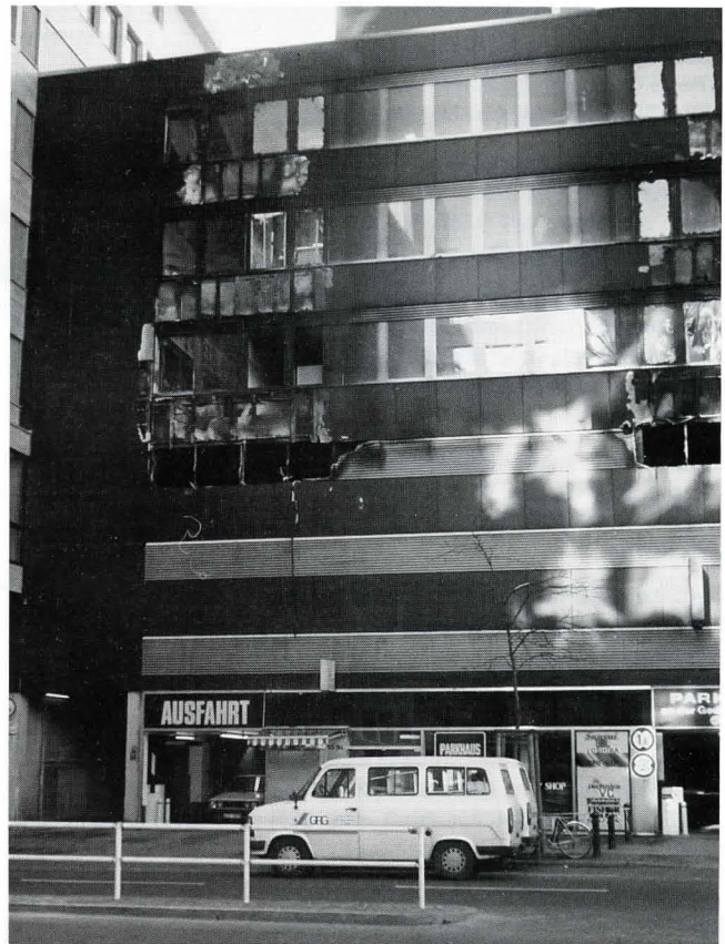
Abb. 4 Alu-Lamellenabdeckungen vor Durchlüftungsöffnungen. Die verbliebenen Lamellen im Brandgeschoß befinden sich im Bereich des Treppenraumes.
