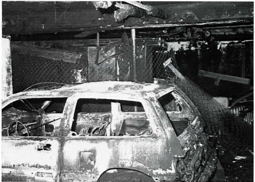
Abb. 3 Ausgebrannter Pkw vor dem durch einen Drahtgitterzaun abgeteilten Lager- und Werkstattbereich.
