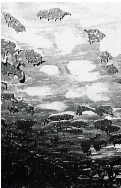
Abb. 5. Blick auf die Decke mit den Klebestellen der Wärmedämmung.
