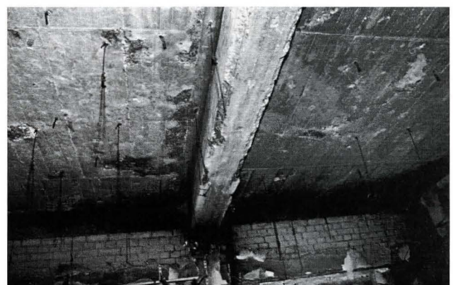
Bild 1: Betonabplatzungen im Deckenbereich Erdgeschoß
