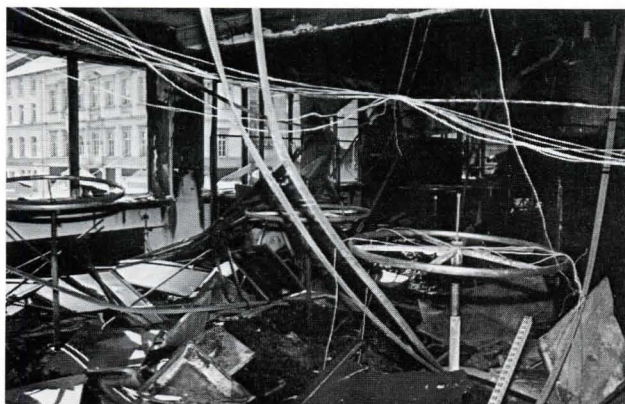
Bild 2. Textilabteilung im Obergeschoß – Abplatzungen im Deckenbereich –
