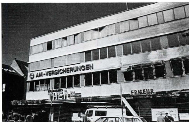
Bild 3. Ansicht des Gebäudes nach dem Brand
