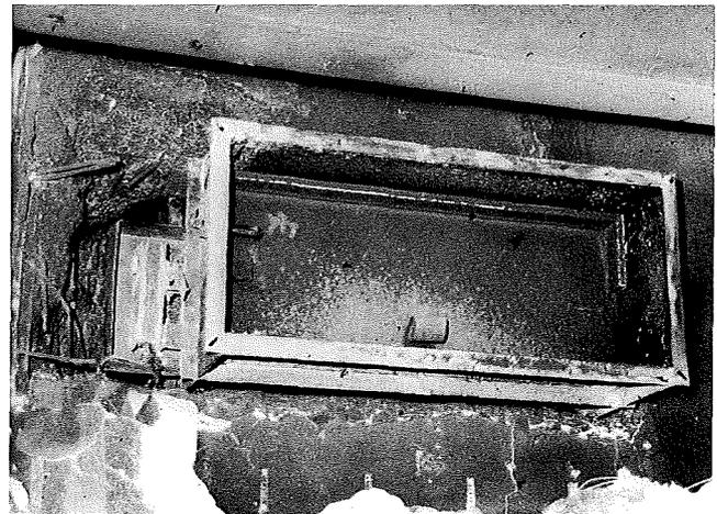
Die mit Schmelzlot gesicherte Brandschutzklappe im Abluftsystem schloß während des Brandes.
