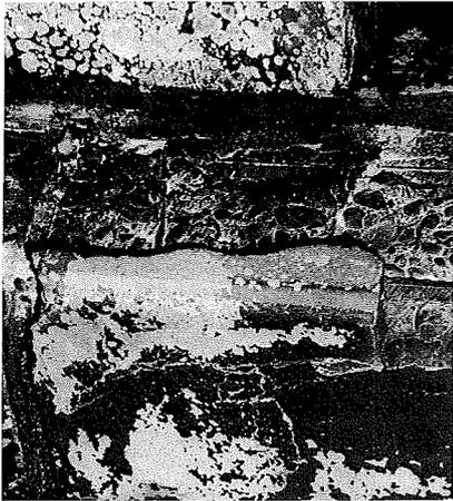
Die Stahlbetonkonstruktion erlitt starke Hitzeschäden; die Betondeckung platzte bis zu den Bewehrungsstäben ab.
