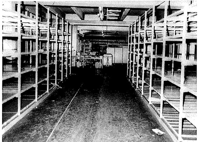
Der Qualm setzte sich und lagerte sich auf allen ebenen Flächen ab. Auf den Regalböden zeichnen sich die Stellen als helle Streifen ab, an denen während der Verqualmung Lagergut lag. Dieses ist inzwischen zur Reinigung entfernt worden.
