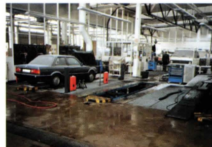
Die Kraftfahrzeug-Werkstatt mit der Unterfluranlage
