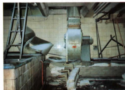
In der Unterfluranlage - zerstörter Exhaustorsockel - deformierte Blechkanäle
