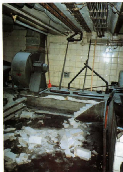
Unterfluranlage mit zerstörtem Exhaustorsockel
