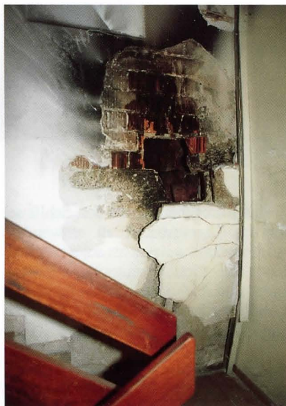
Ansichten zu Bild oben, vom Treppenraum aus gesehen. Der Kranbahnträger dehnte sich mehr als 20 cm aus und zerstörte sogar die Stahlbetonwand.
