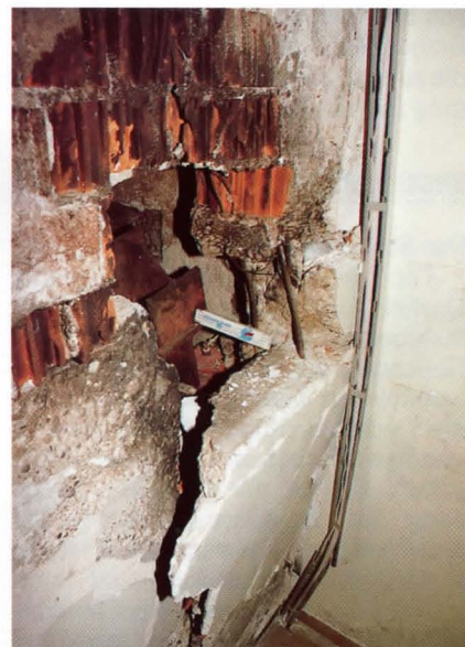
Ansichten zu Bild oben, vom Treppenraum aus gesehen. Der Kranbahnträger dehnte sich mehr als 20 cm aus und zerstörte sogar die Stahlbetonwand.
