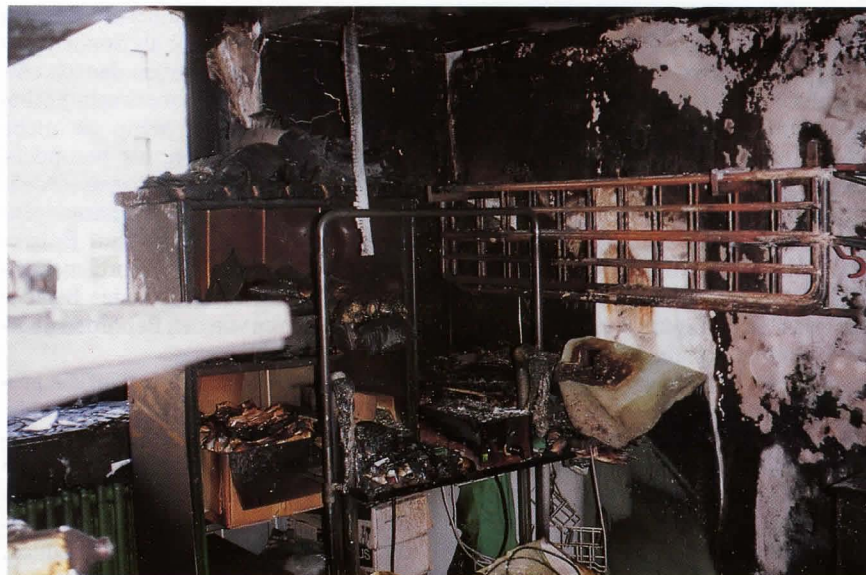
Bild 1: Vom Brand betroffener Bereich
