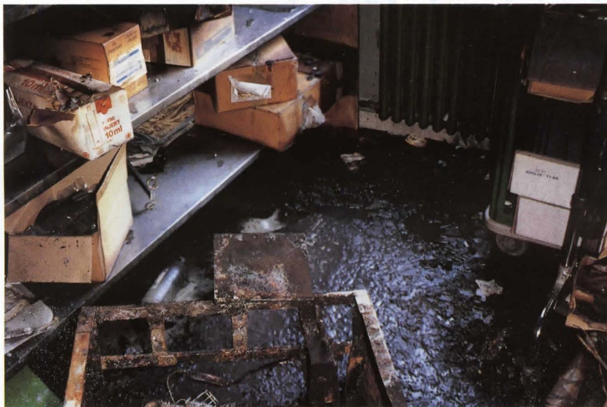
Bild 3: Dieser Bereich muß auch „entkern“ werden.
