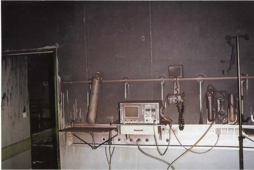
Bild 2: Meßgeräte und andere empfindliche Einrichtungen die „kaltem“ Brandrauch ausgesetzt waren, müssen von Spezialfirmen saniert werden.
