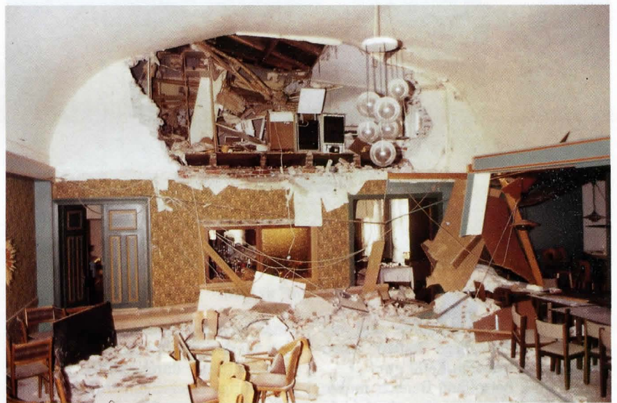
Abb. 1: Blick vom Saal durch die zerstörte Wand in die Küche der Ferienwohnung.
