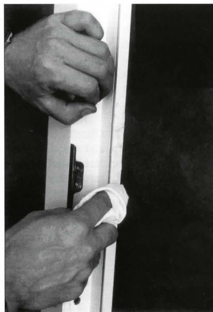
Bild 6: Auspolieren der Übergänge
