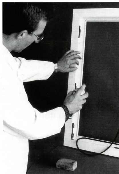
Bild 5: Beschichten der Oberfläche
