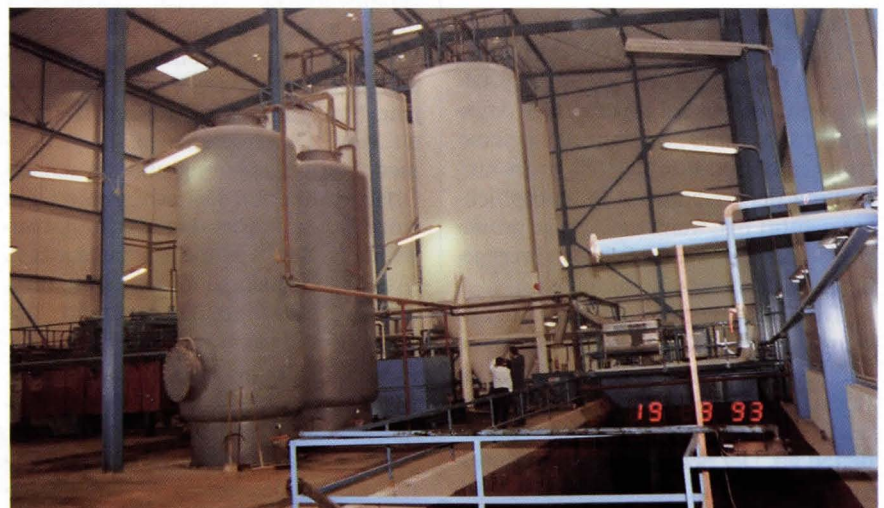
Abb. 3: Chemisch-physikalische Behandlungsanlage für besonders überwachungsbedürftige Abfallstoffe
