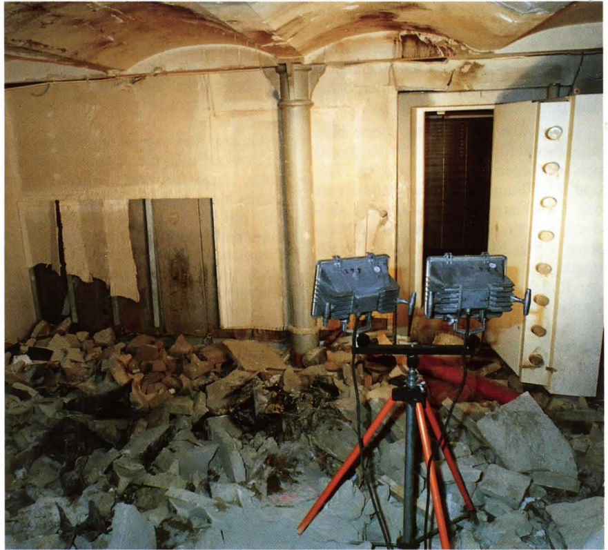
Von Trümmern übersät – der Kellerraum der Bankfiliale. In der Bildmitte zu erkennen eine gußeiserne Stütze. Foto: K. Keikus, Berlin
