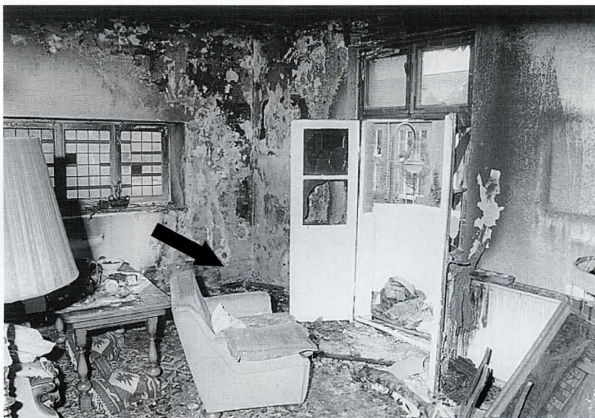
Bild 1: Brandursache – technischer Defekt eines Fernsehgerätes
