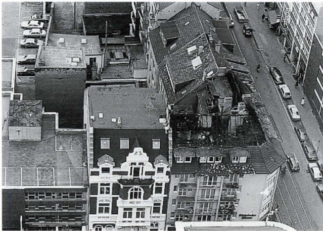
Bild 4: Brandort - Dachstuhl eines mehrstöckigen Wohnhauses
