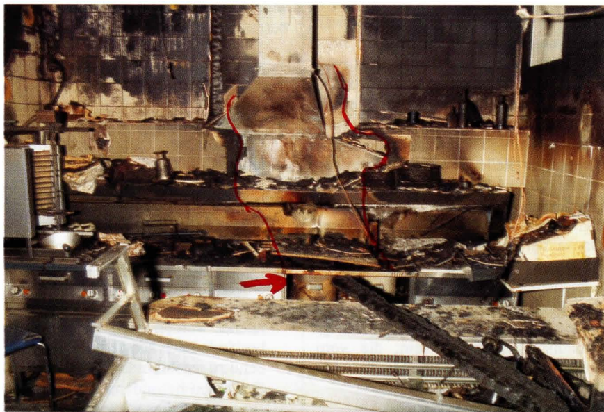
Abb. 1: Blick auf den Brandschwerpunkt (markiert) oberhalb der Doppelfriteuse (Pfeil)
