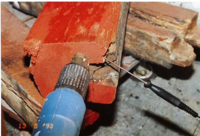
Bild 3: 2. Versuch-Heißluftpistole und Temperaturlaufnehmer in Position
