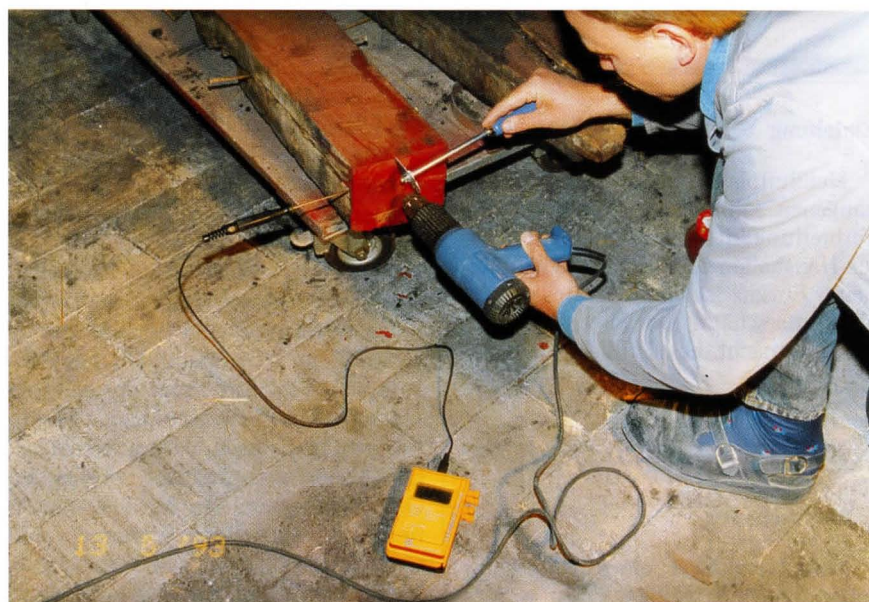
Bild 1: 1. Versuch-Entfernen der Farbe mit Heißluft und Schaber – Temperaturmessung hinter der Hirnholzfläche
