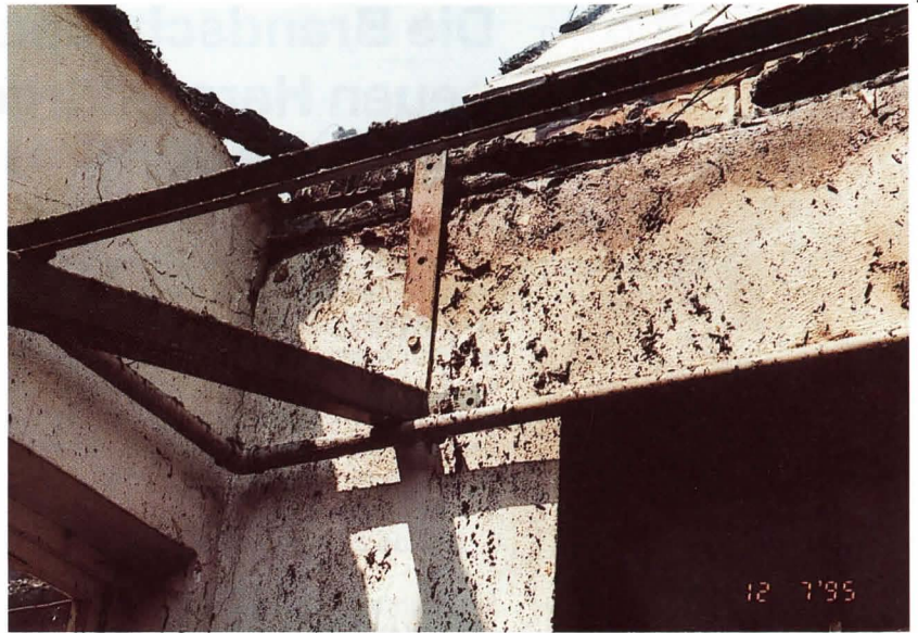
Bild 3: Zu sehen sind die Winkeleisen der Überdachung. Der obere Mauerwerksabschluß ist 1,73 m entfernt, wo die schilfgedeckten Dachbalken auflagen.
