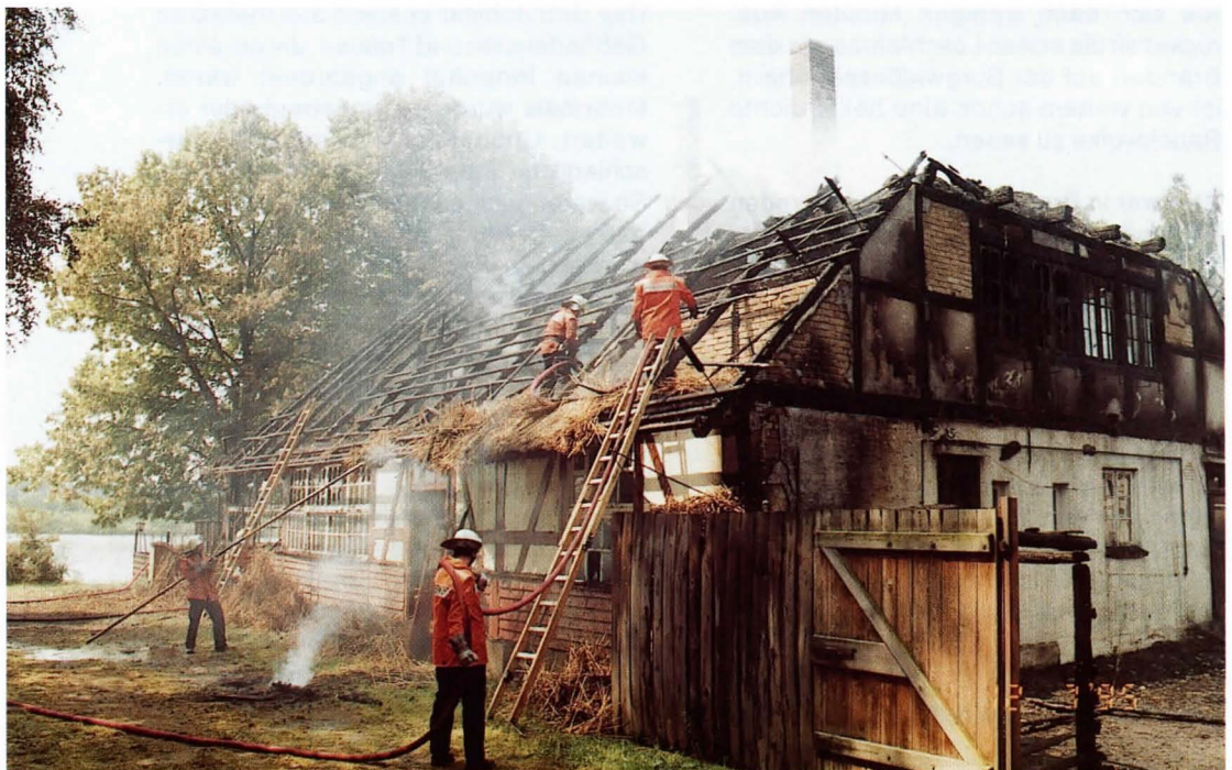
Bild 2: Die Feuerwehr bei Restlöscharbeiten an der Südseite. Das Tor zum Hof führt zu einer Stahlkonstruktion (Überdachung), die in Bild 3 zu sehen ist.
