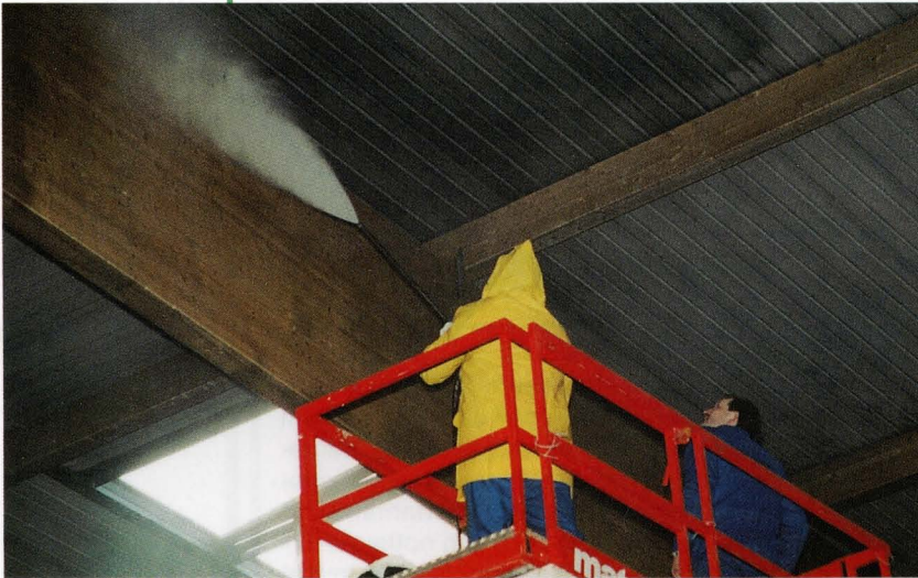
Sanierung von Stahltrapezdecken im Hochdruckwaschverfahren.
