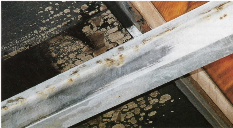
Die Verwendung ungeeigneter Sanierungschemikalien führte an diesem verzinkten Stahlträger zu Korrosionen.
