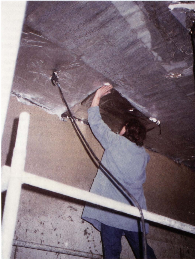
Aufbringen der Aluminiumfolie für die Elektrosanierung zum Entfernen brandbedingter Chloride nach einem Großschaden
