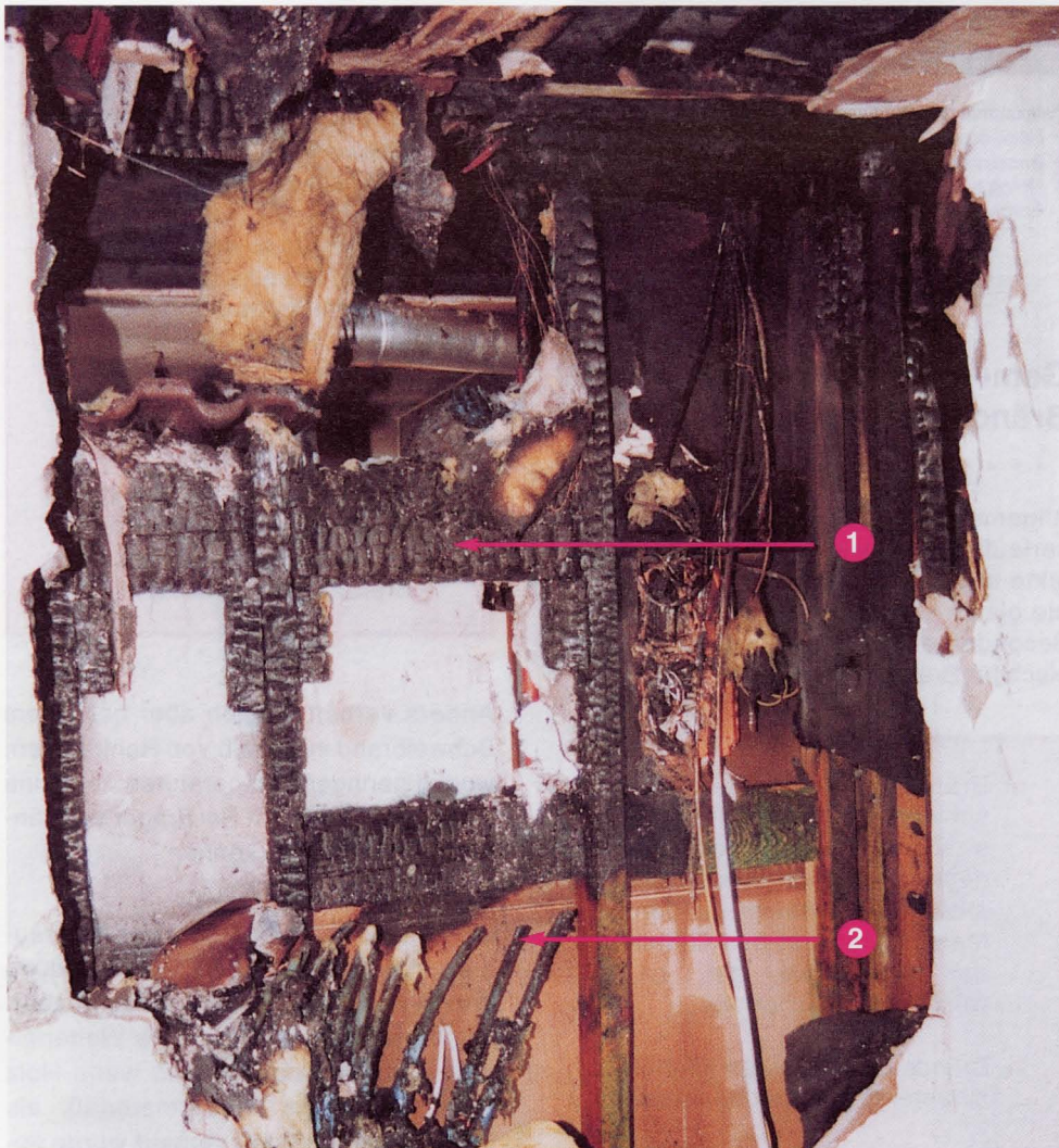
Übersichtsaufnahme des ehemaligen Installationsortes des Heizkreisverteilers im Erdgeschoß
