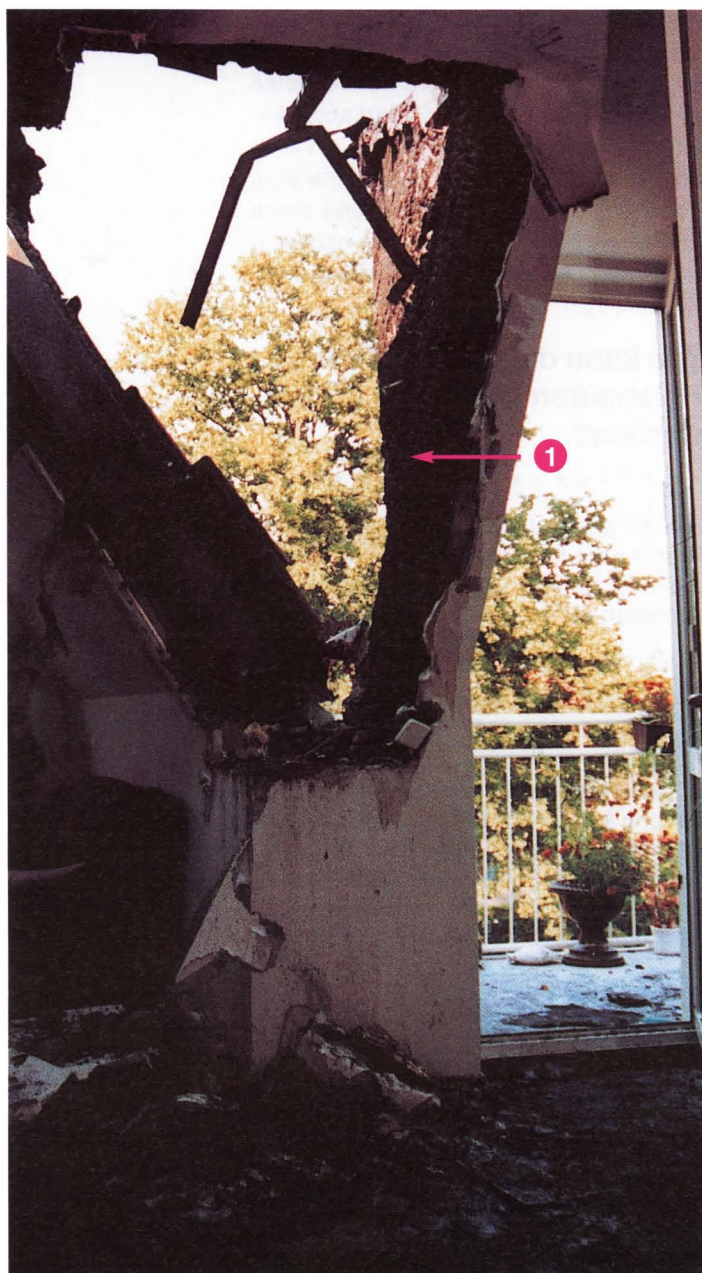
Übersichtsaufnahme des Brandkanals in der Wand 1 massive Brandwaffelung an den Holzbauteilen in der Wandkonstruktion
