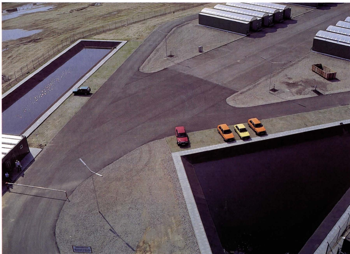
Abb. 1 Löschwasser-Rückhaltebecken in einem Chemikalienlager
