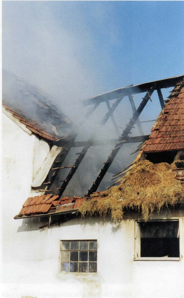
Bild 1: Die Schadenursache war hier das Anlegen von leicht entzündlichen Stoffen, wie z.B. Stroh, an Leuchten
