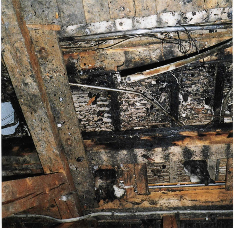
Bild 2: Brandursache unsachgemäße Installation elektrischer Anlagen
