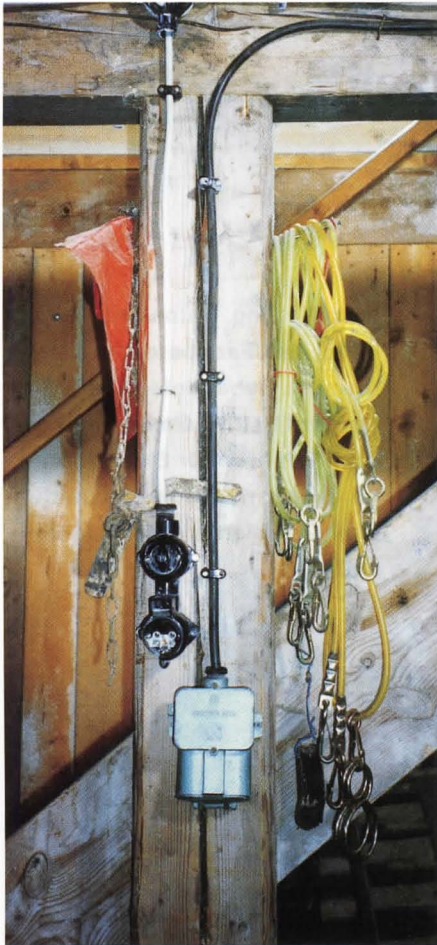
Bild 3: Unzulässige Installation von Leitungen auf brennbarem Untergrund
