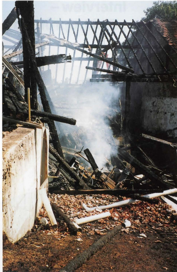
Bild 4: Eine mechanisch beschädigte bewegliche Leitung als Brandstifter
