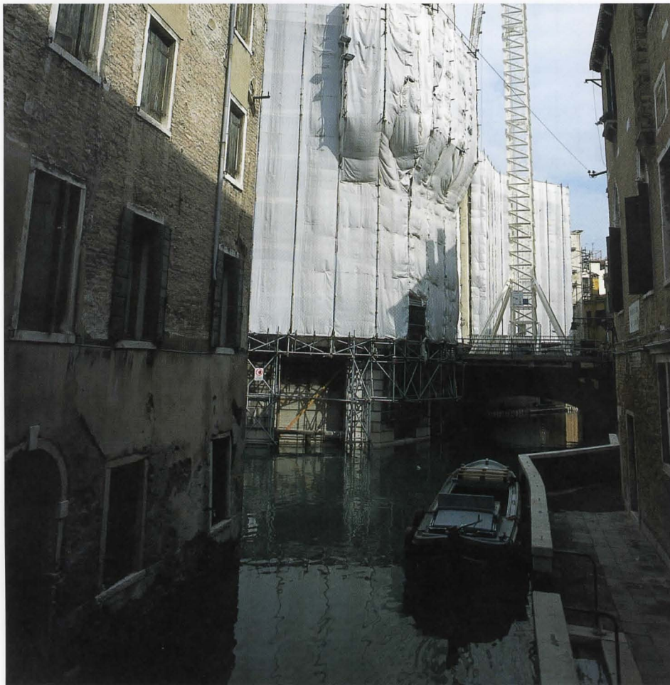
Bild 3: Die im Wiederaufbau befindliche Oper in Venedig, welche am 29.01.1996 völlig ausbrannte
