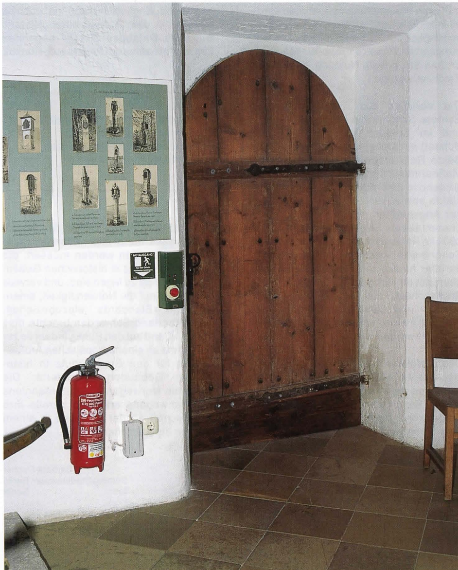
Bild 4: Rettungswegetechnik in historischer Bausubstanz – Burghausen
