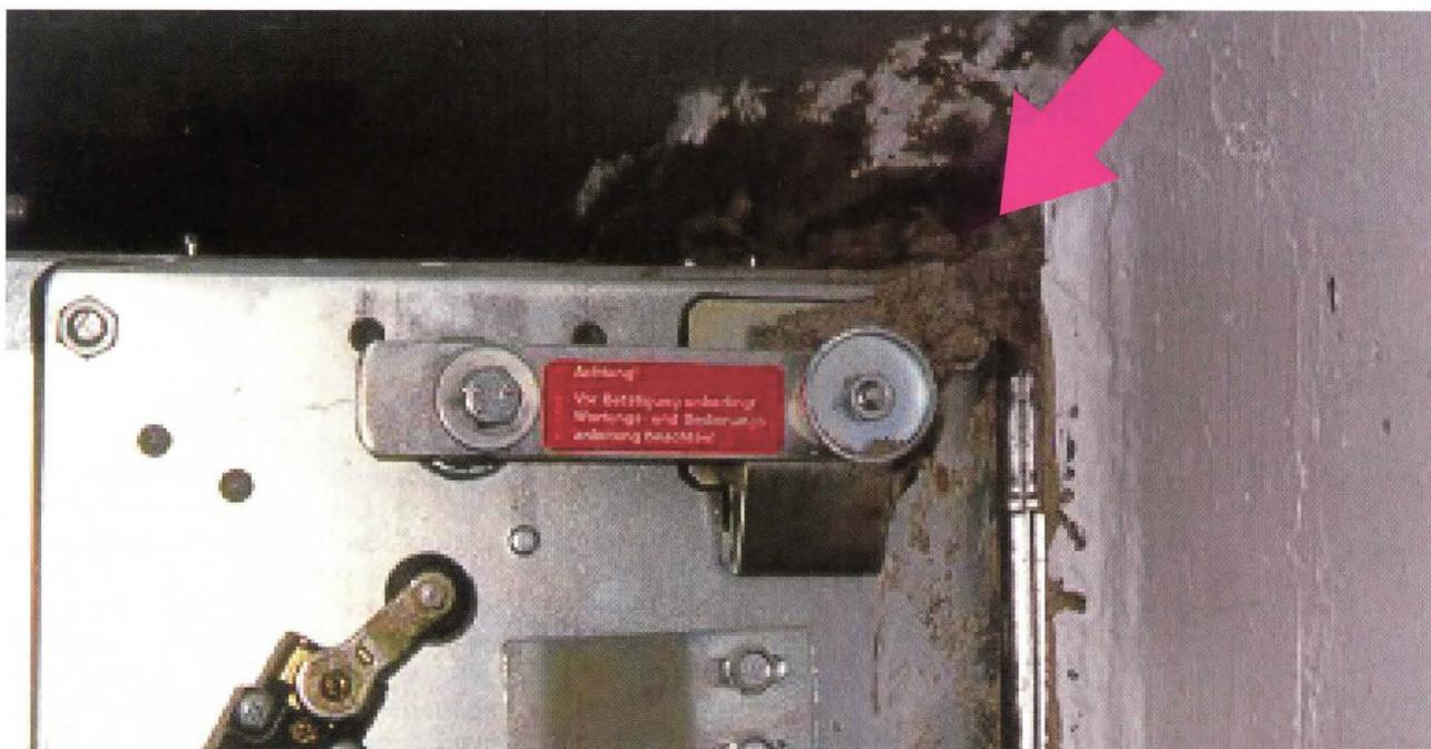
**Bild 9:** Fahrlässig eingebaute Absperrvorrichtung. Der abgebundene Mörtel hätte die Auslösung verhindert.
