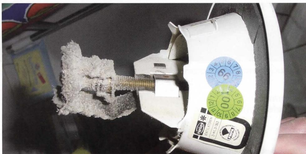
**Bild 3:** Verschmutzte Auslösevorrichtung einer K 90-18017 Brandschutzklappe. Diese Verschmutzung ergab sich (erkennbar durch die Prüfplaketten des Schornsteinfegers) innerhalb des einjährigen Prüfzyklusses. Eine Auslösung bei ca. 72°C ist bei dieser Verschmutzung des Schmelzlotes und der Auslösefeder stark anzuzweifeln!
