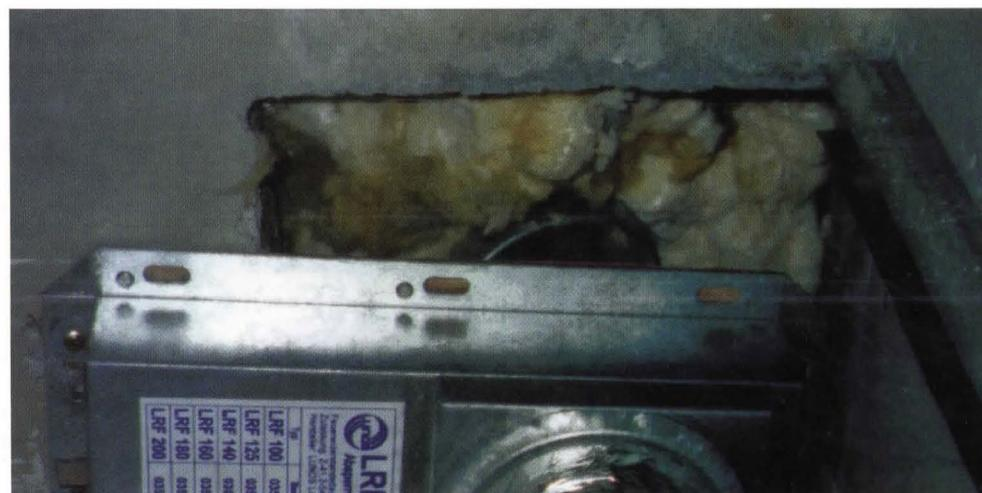
**Bild 4:** Der Einbau der AV erfolgte nicht entsprechend den Vorgaben der „Bauaufsichtlichen Zulassung“. Es wurde brennbarer Bauschaum verwendet!
