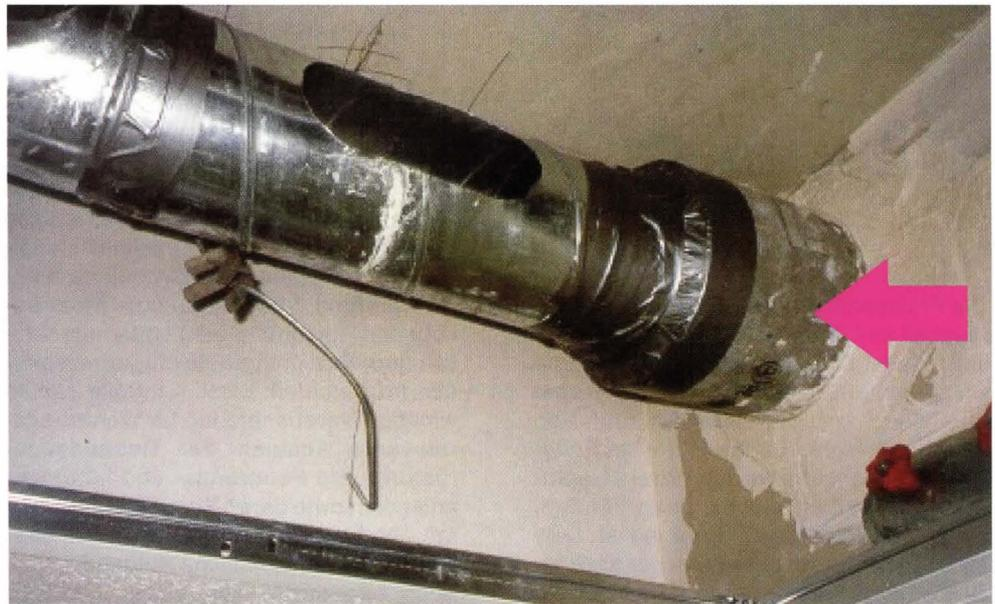
**Bild 8:** Veränderung nach Beauftragung durch den Bez.-Schornsteinfegermeister. Einbau einer Absperrvorrichtung erfolgte in der Schachtwand. Zur Inspektion und Wartung der Brandschutzklappe wurde eine zugängliche Revisionsöffnung erstellt. Die Kennzeichnung der konkreten Lage ist lt. Zulassungsbescheid mit dem zum Lieferumfang gehörenden Schild vorzunehmen.
