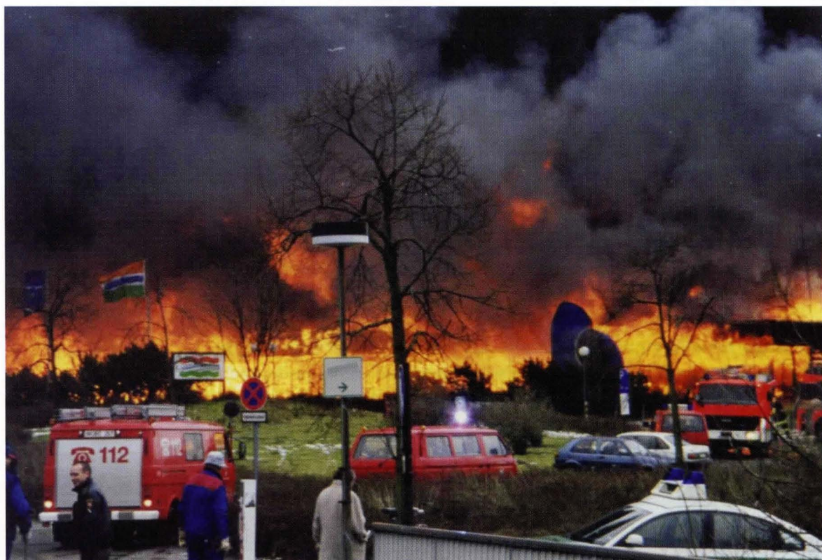
Bild 1: Brandschaden an einem Hallenbad
