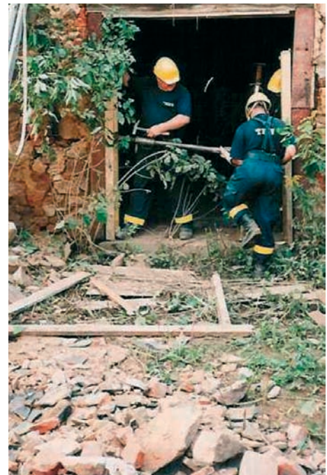
Bild 5: Anlegen eines Zugangstunnels
