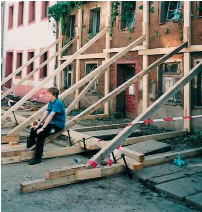
Bild 4: Vor Ort gezimmerte Absteifung für die durchfeuchteten Außenwände
