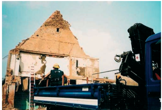
Bild 7: Das THW im Einsatz
