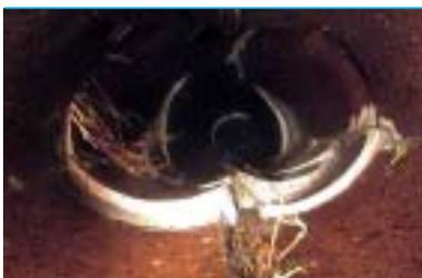
**Bild 2:** Durchbruch in einer undichten Abwasserleitung.
