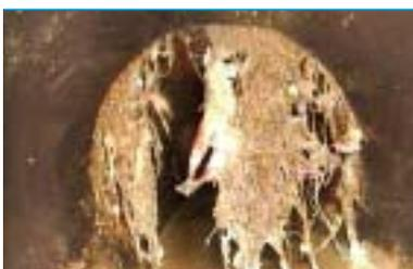
**Bild 3:** Wurzeleinwuchs in undichte Rohrverbindung.
